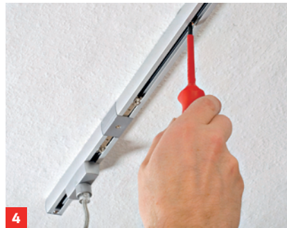
4 Schließlich Schiene an allen Befestigungspunkten in den zuvor gesetzten Dübeln an der Decke verschrauben
