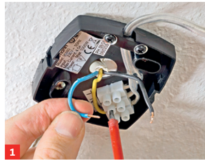
1 Zum System gehörende Anschlussdose am Stromanschluss montieren, Zuleitung der Einspeisung anschließen
