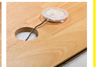
3 Die LED-Träger werden in Kreuzfugen eingelegt und mit verfugt. Dabei muss das LED-Glas frei bleiben
