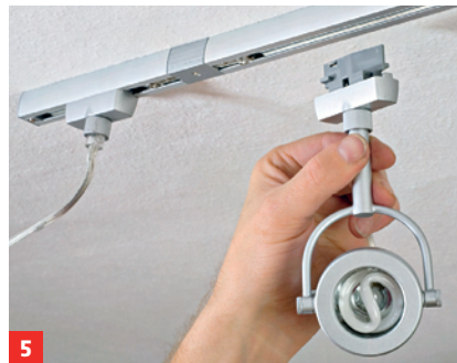
5 Die Lampenträger können nun von unten in die Schiene eingesetzt und an fast jeder Position fixiert werden
