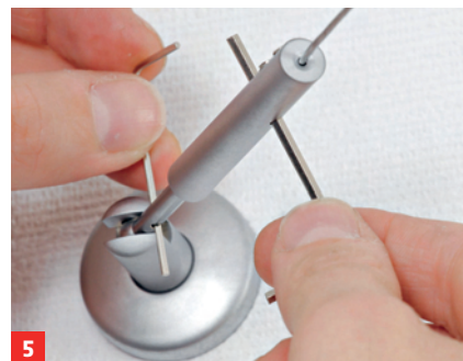
5 Auf der anderen Wandseite können die Seile mit einer Gewindemechanik auf die gewünschte Spannung gebracht werden
