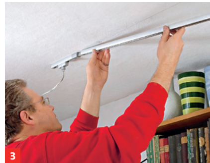
3 Zunächst an den zuvor markierten Stellen Dübel setzen, dann Schienenabschnitte Zug um Zug ankoppeln
