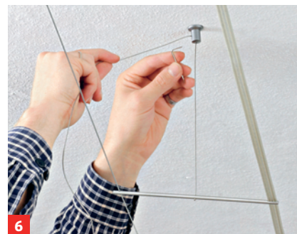
6 Zusätzliche Deckenhalter tragen später die Last der angeschlossenen Leuchten mit, bei kurzen Wandabständen sind sie verzichtbar
