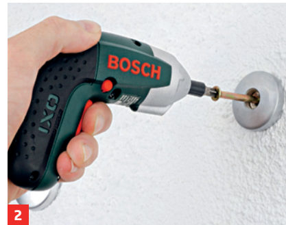
2 Die Verschraubung der Wandanker erfolgt verdeckt und ist bei diesem System später nicht mehr sichtbar
