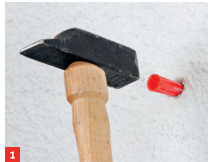
1 An den Haltepunkten wirken später hohe Zugkräfte. Daher für den Wandbaustoff geeignete Dübel wählen
