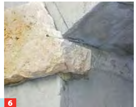
3 Beginnen Sie mit einem Eckstein, den Sie andrücken bzw. hin- und herschieben, bis der Kleber seitlich herausquillt.
