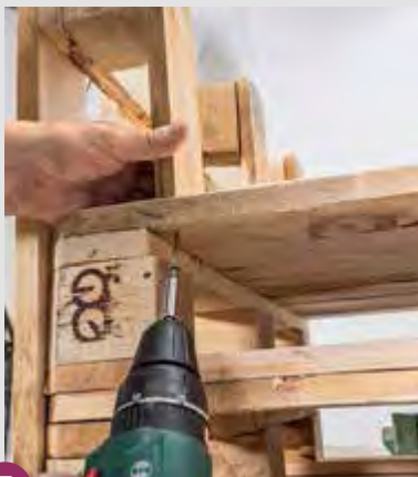
5 Von unten schraubst du den innen aufliegenden kürzeren Abschnitt fest.
