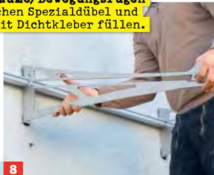
**8** Den Mörtel aushärten lassen (bis zu 24 Stunden), dann die Träger montieren. Benutzen Sie einen Drehmomentschlüssel!
