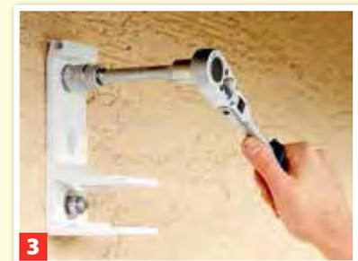
**3** Nach Aushärtung des Mörtels die Konsolen mit Sechskantmuttern an den Ankerstangen befestigen.
