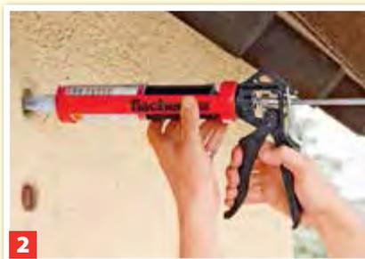
**2** Löcher reinigen, Ankerhülse einschieben, Injektionsmörtel einbringen und Ankerstange mit Konus einführen.
