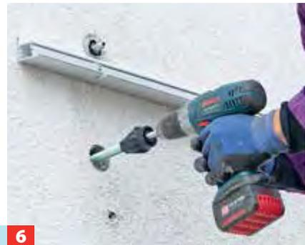
**6** Den *Thermax* mit Sechskant-Bit eindrehen. Die Außenkante muss mindestens 1 mm über der Putzoberfläche liegen.
