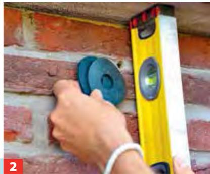
**2** ... flexible Unterlegscheiben aus Kunststoff, damit die Verschraubung fest, rostfrei und schallgeschützt gellingt.
