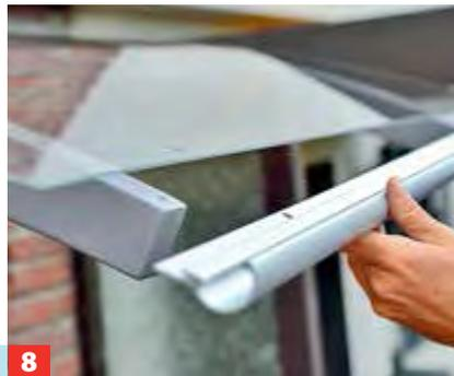
**8** Es folgt die vordere Profilschiene, die auch als Dachrinne dient. Schieben Sie sie unter die Acrylglasplatte.
