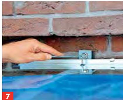
**7** Durch die Bohrpunkte des Daches und der Schiene beides mit den Bögen verschrauben.
