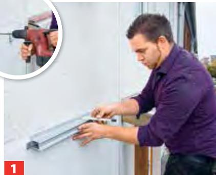
**1** Profil in gewünschter Höhe anhalten, Löcher anzeichnen und bohren. Das leichte Aluprofil mit Nyloodübeln verschrauben.
