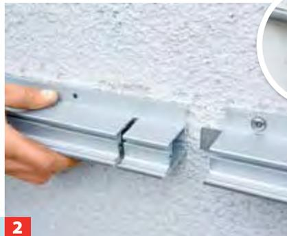
**2** Mittig folgt das Profil des Erweiterungsmoduls. Es wird seitwärts in das erste Profil hineingeschoben und verschraubt.
