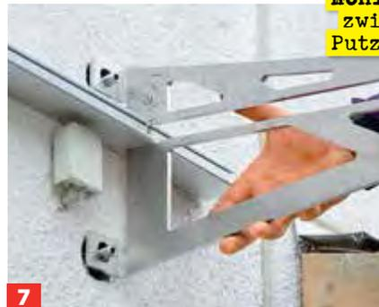
**7** Träger probeweise über die herausstehenden Gewindestifte an die Wand setzen und die Spezialdübel ggf. nachjustieren.
