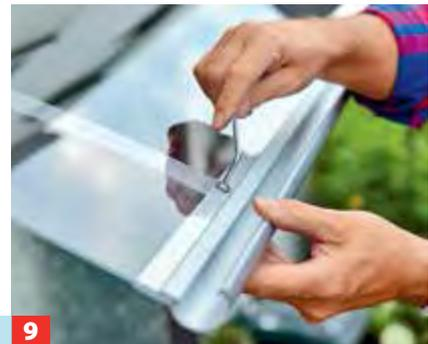
**9** Dann wird das Profil und die Scheibe wie wandseits durch die Bohrpunkte mit den Vordachbögen verschraubt.
