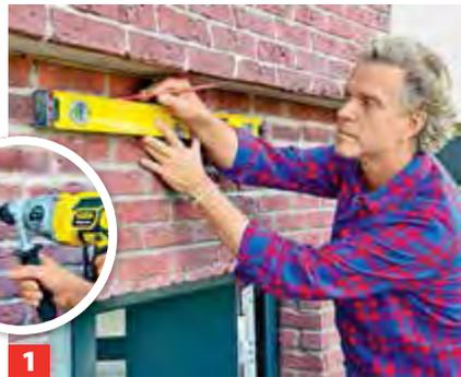
**1** Die vier Bohrpunkte der beiden Vordachbögen markieren und Löcher bohren. Unter die Bögen kommen ...
