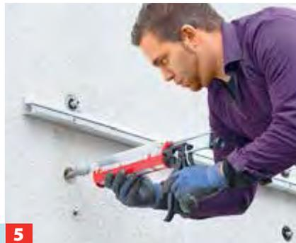
**5** Bei Vollstein/Beton in das gereinigte Bohrloch Injektionsmörtel spritzen<sup>3)</sup>, bei Lochstein vorher eine Ankerhülse setzen.
