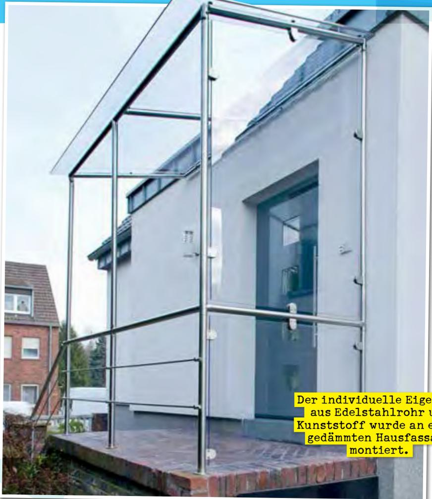
Der individuelle Eigenbau aus Edelstahlrohr und Kunststoff wurde an einer gedämmten Hausfassade montiert.
