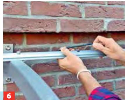
**6** Die Profilschiene hinten an die Wand halten und das Acrylglasdach in die rückseitige Profilschiene schieben.
