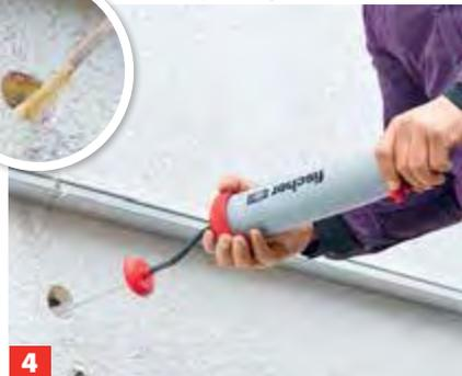
**4** Träger abnehmen, *Thermax* eindrehen und Dämmung mit Konus ausfräsen.<sup>2)</sup> *Thermax* entnehmen und Löcher reinigen.
