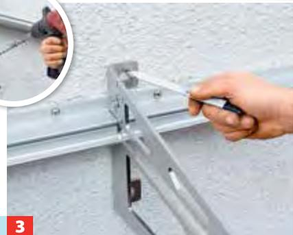
**3** Edelstahlträger einhängen, Löcher anzeichnen und bohren, in Vollstein/Beton durch die Dämmung 125 mm in den Stein.
