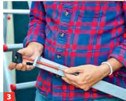
**3** Dübel durch die Montagelöcher stecken, Unterlegscheibe über die Dübel stülpen und die Bögen festschrauben.
