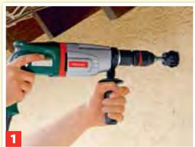
**1** Anti-Kälte-Konus auf der Ankerstange fixieren, beiliegenden Sechskantbit aufsetzen und Dämmung aufträsen.
