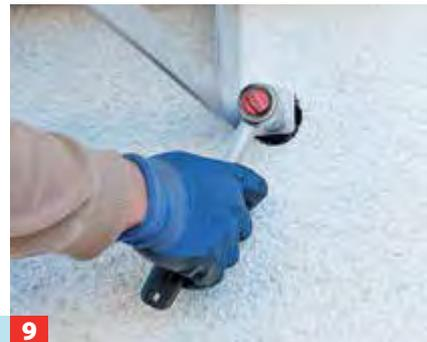
**9** 20 Nm Anzugsmoment einstellen; das Bauteil darf sich nach dem Anziehen nicht auf dem Untergrund abstützen!
