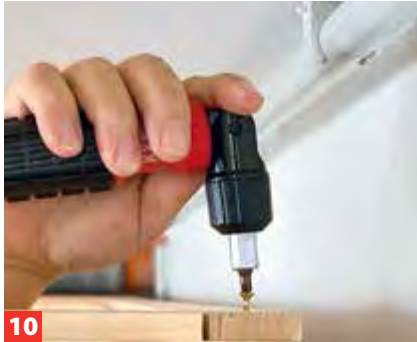
10 Diese mit 3,5-x-35-mm-Schrauben auf den Wandelementen befestigen.
