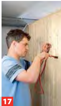
14 Abschließend folgen an der Innenseite rundum Tragleisten und umlaufend das Deckdichtband, das geklebt wird.
