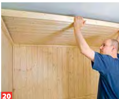
20 Restliche Eckleisten festnageln und die Deckenelemente auflegen. Achtung: Die Mindestraumhöhe muss 2,05 m betragen!
