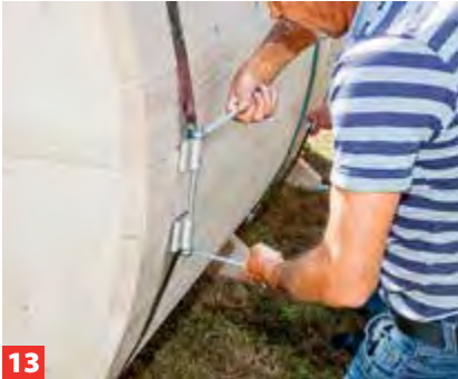
13 Danach die Spannbänder herumlegen und bis zum ersten Widerstand spannen. Nach drei Wochen nachspannen!
