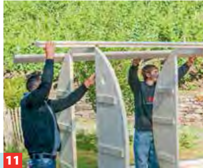
11 Um das Fass provisorisch für die Montage der Seitenbohlen zu stabilisieren, bringen Sie zunächst eine Bohle am First an.
