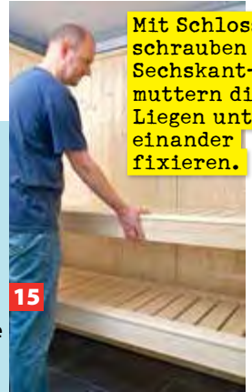
Nun kommt die Inneneinrichtung. In angegebener Höhe (hier 38 und 82 cm) die Halterungen für die Liegen festschrauben.
