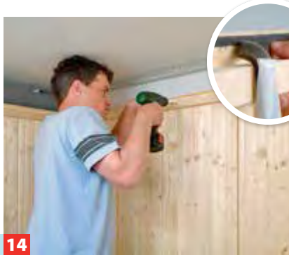
14 Abschließend folgen an der Innenseite rundum Tragleisten und umlaufend das Deckdichtband, das geklebt wird.
