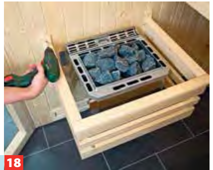
Nun kommt die Inneneinrichtung. In angegebener Höhe (hier 38 und 82 cm) die Halterungen für die Liegen festschrauben.
