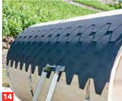
14 Jetzt die Dachschindeln immer überlappend versetzt auf die obere Fasshälfte nageln. Für das Ofenrohr wird an ...
