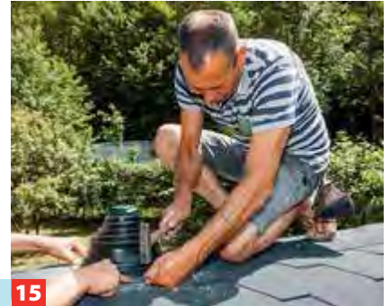
15 ... entsprechender Stelle ein Loch ins Dach gesägt, dann eine Manschette aufgenagelt und das Rohr eingesetzt.
