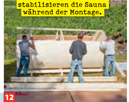
12 Nun werden die Seitenwände Brett für Brett hochgezogen. Achtung: Immer abwechselnd rechts und links arbeiten!
