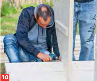
10 Die Wandelemente exakt ausrichten und mit den Bodendielen verschrauben.
