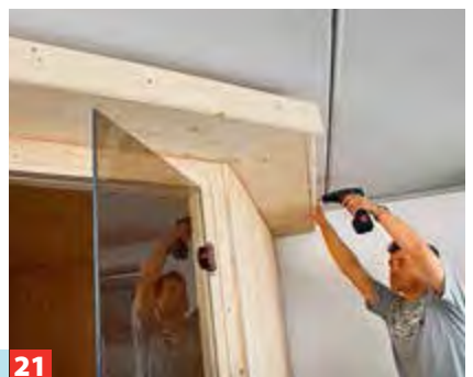
21 Ggf. Kranzprofil und beiliegende Blende verschrauben und Einbauspots montieren.
