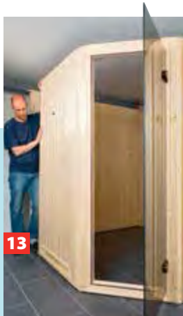
Das nächste Wandelement links von der Tür aufstellen und ebenfalls mit dem Türelement verschrauben.
