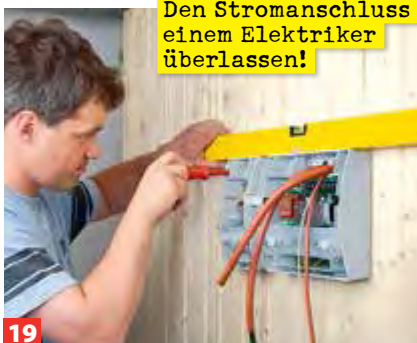
19 Kabel durch das Steuergerät führen, dieses ausrichten und am Wandelement festschrauben.
