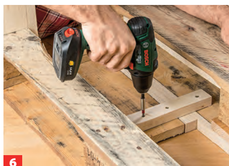
Für die Stabilität der Tischplatte wird nahe der Schnittstelle von unten eine kurze Leiste gegengeschraubt.
