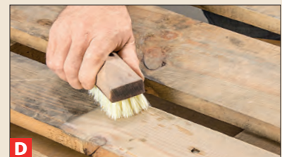
D Mit Seifenlauge und einer Wurzelbürste entfernen Sie Dreck und Abdrücke.
