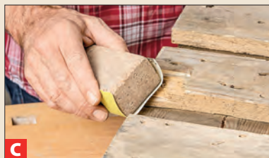
C Gesplitterte oder beschädigte Stellen mit etwas Schleifpapier glätten.
