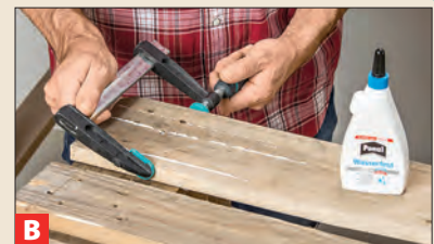
B Risse können Sie vorsichtig aufweiten, mit Leim füllen und zusammenzwingen.
