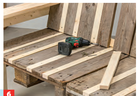
6 Die Lücken werden mit passgenauen Holzleisten gefüllt und diese verschraubt (siehe Bild 9 und 10 oben).
