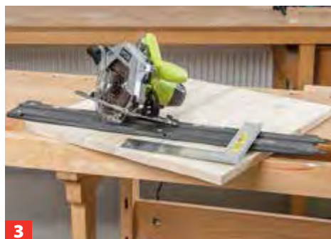
3 Nach dem Abbinden des Leims besäumen Sie die drei Platten (zwei Seiten, ein Rücken) rechtwinklig auf das benötigte Maß.
