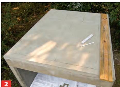
2 Reißen Sie den Grundriss des Ofenkerns auf. Wenn die Betonfläche stark sandet, sollten Sie sie vorher grundieren\*.
