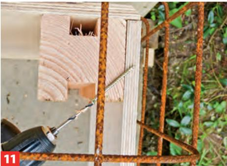
**11** Die innere Seitenschalung schrauben Sie von Innen durch das Kantholz fest. Hier auch gut sichtbar: der Schrägschnitt der ...
