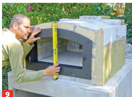
Dann die Tür aus dem Rahmen nehmen, den Rahmen einsetzen und ausrichten.
