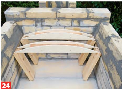
**24** Stellen Sie die Stützen in den Backraum und richten sie so aus, dass jedes der drei Gewölbesegmente sicher aufliegen kann.
