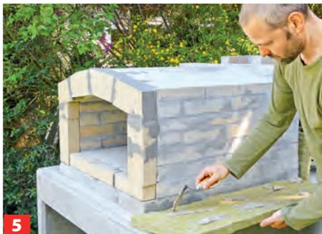
Sie wird rundum doppellagig mit Isolierplattenkleber auf die Außenwände geklebt. Den Kleber punktuell auftragen ...
