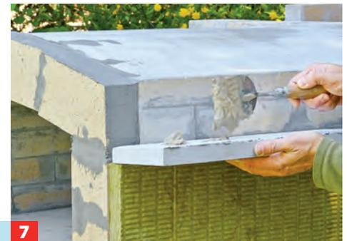
Im oberen Drittel wird anstatt der weichen die druckfeste Isolierplatte aufgeklebt.
