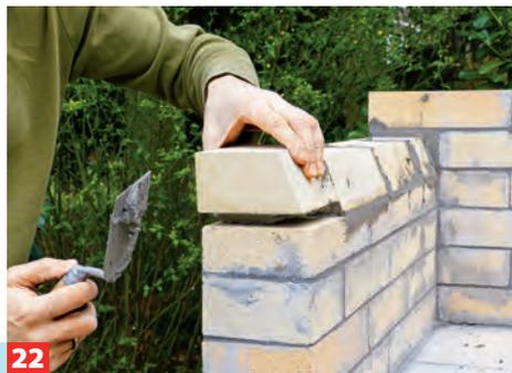
**22** Die so zugeschnittenen Steine werden im Anschluss vermauert.
