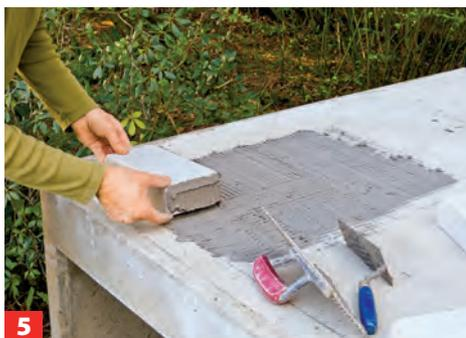
5 Abschnittsweise den Schamottemörtel mit der Zahnkelle aufziehen und die Steine einlegen. Auch die Stoßfugen der Steine ...
