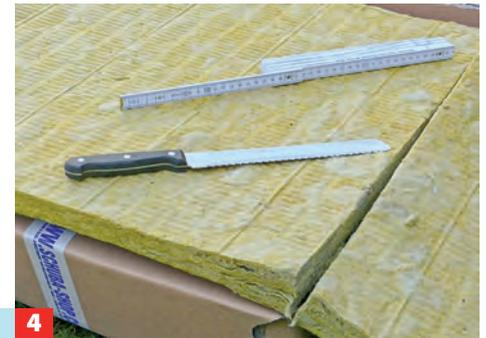
Die weiche Isolierplatte schneiden Sie einfach mit dem Brotmesser zu.
