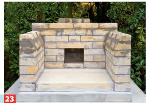
**23** So sieht das Bauwerk inzwischen aus. Nun folgt der Bau der Schalungsstützen für das Gewölbe.
