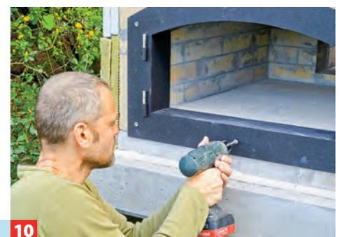
Die Tür wird mit Spezialschrauben montiert. Löcher mit dem Bohrer vorbohren und Schrauben behutsam eindrehen.
