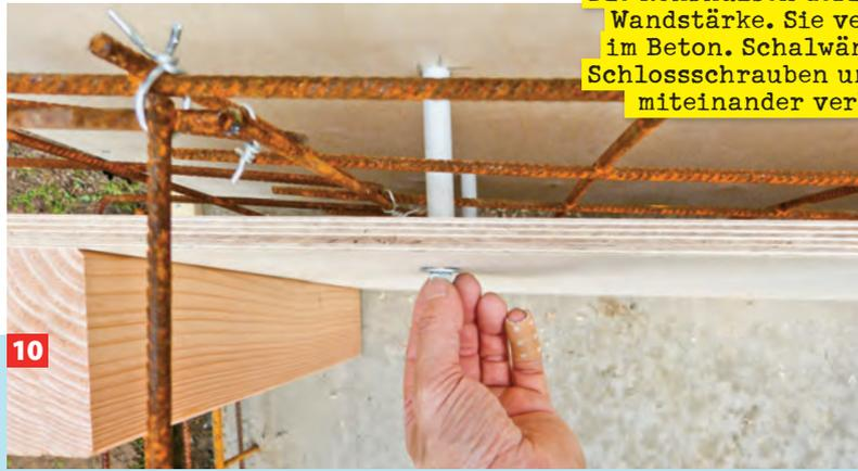
Die Rohrhülsen definieren die Wandstärke. Sie verbleiben im Beton. Schalwände durch Schlossschrauben und Muttern miteinander verbinden.
