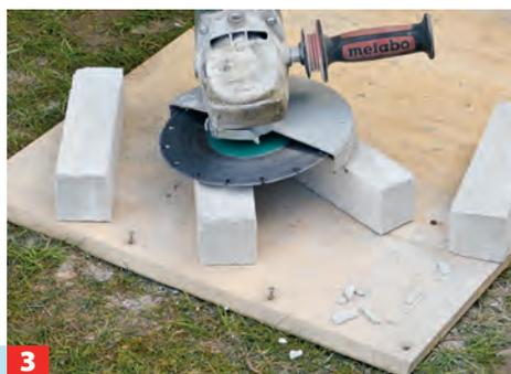
3 Schneiden Sie die Isoliersteine gemäß der Angaben im Bauplan zu.
