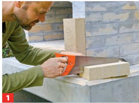
Der Backraum wird zur Tür hin mit Feuerleichtsteinen beklebt. Diese lassen sich mit der Handsäge zuschneiden.
