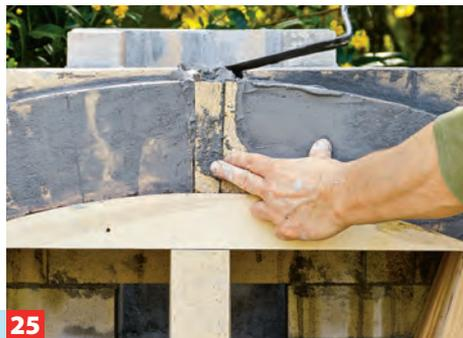
**25** Die Schamottewölber werden nun von beiden Seiten her vermörtelt. Der mittlere Stein wird aus einem Wölber zugeschnitten und ...
