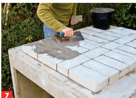
7 Zum Schluss können Sie die Fugen noch nachverfüllen und die Fläche dünn mit feuerfestem Mörtel abziehen.
