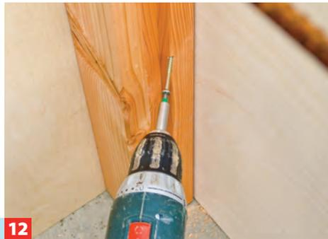
**12** ... hinteren, inneren Schaltafel. Die so eingedrehten Schrauben lassen sich zum späteren Ausschalen noch gut erreichen.
