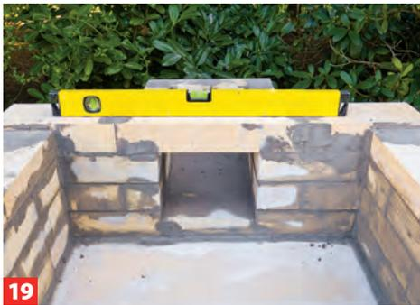
**19** Nach der vierten Steinlage wird das Abzugsloch oben abgeschlossen. Hierfür liegt ein 375 mm langer Schamottestein bei.
