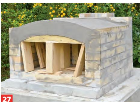
**27** Die Fugen wurden alle gründlich nachverfüllt, die (auf Keile gesetzten) Gewölbestützen können Sie anschließend entfernen.
