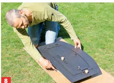
Nun geht es an den Einbau der Tür. Fertigen Sie jedoch zuerst eine Schablone für die Schalung der vorderen Betonplatte.
