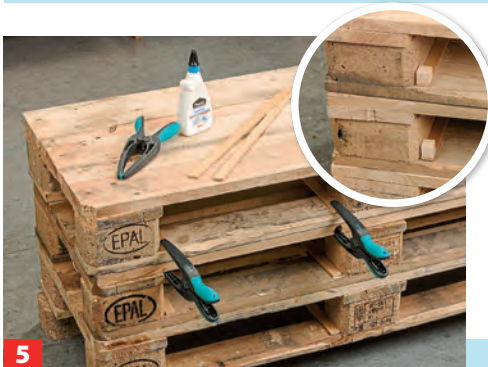
2 Die Ebenen miteinander verschrauben (siehe li. Seite), auf den Kopf stellen und die Füße verleimen, zum Trocknen fixieren.
