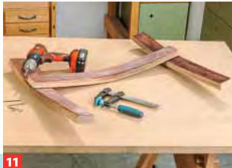
**11** ... abgelängt, da die Fassbodenkerben hier stören würden. Auch hier gilt: erst bohren und senken, dann schrauben.
