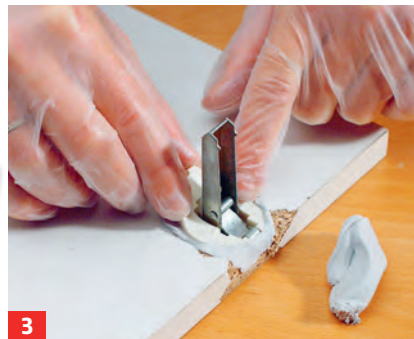
1 Ein ausgebrochenes Scharnier ist mit üblichen Mitteln aufwendig zu reparieren – hier befindet man sich im ...
