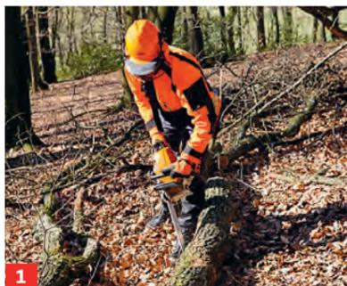
**1** Liegende Baumstämme oder Kronen werden zunächst mit der Kettensäge entastet.
