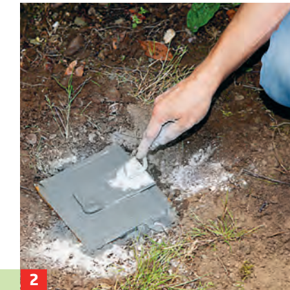
2 Beton einfüllen, die Oberfläche glätten und ca. zwei Tage abbinden lassen. Aufschraubbaren Stützenschuh ...
