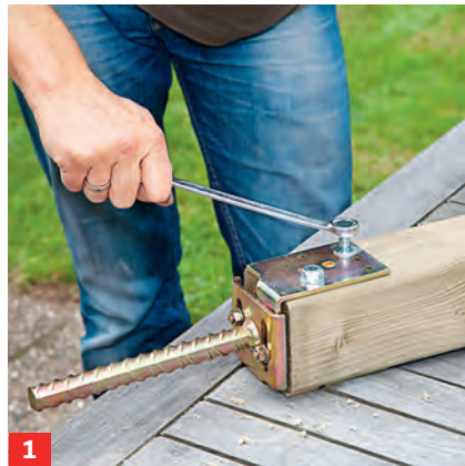
1 Einbetonierbaren U-Schuh ggf. auf die Pfostengröße einstellen. Pfosten einsetzen, vorbohren und verschrauben.
