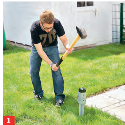
1 Bodenhülse senkrecht in den Boden drücken. Einschlagwerkzeug einsetzen, mit kräftigen Schlägen eintreiben.
