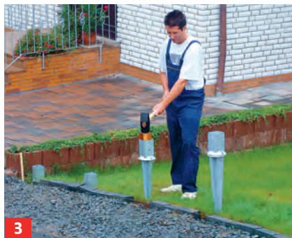
3 Die Bodenhülsen können anschließend einfach eingeschlagen werden; ein Kantholz dient als Einschlaghilfe.
