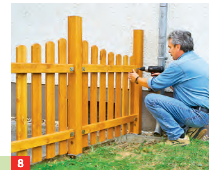
8 Element mit Kanthölzern abstützen und fixieren, dann an beiden Seiten mit den Zaunhaltern verschrauben.
