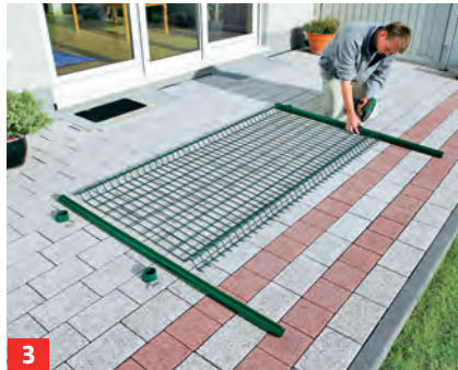
3 Das erste Gitterelement auf den Boden legen und vormontieren: Pfosten, Gitter und Montagebügel.
