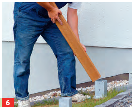
6 Die abgelängten Pfostenenden mit Bangkirai-Öl bestreichen und in die Hülsen setzen.
