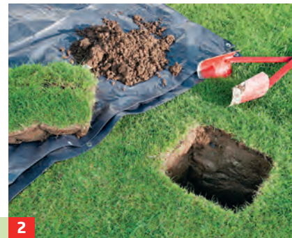
2 Die Fundamentlöcher 30 x 30 cm groß und am besten 80 cm tief ausheben.
