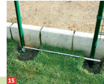
15 Die Positionen der Torpfosten markieren, Fundamentlöcher ausheben und Pfosten einbetonieren.
