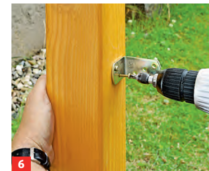
6 Markieren Sie die Höhe der Querlatten eines Zaunelements und setzen Sie auf dieser Höhe die Zaunhalter.
