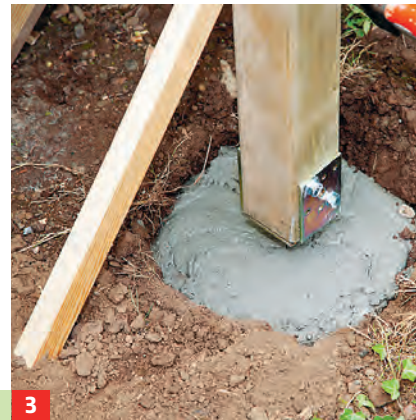
3 Nun den angemischten Beton (siehe Kasten Seite 7) einfüllen und mindestens zwei Tage abbinden lassen.
