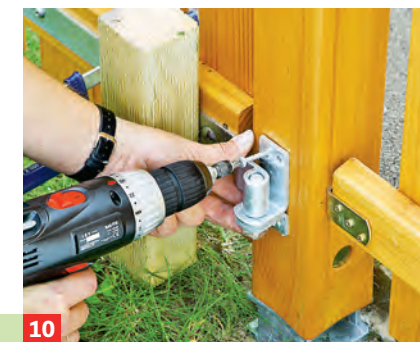
10 In entsprechender Höhe die Scharniere am Zaunpfosten verschrauben.
