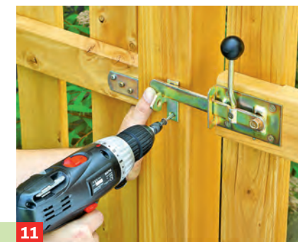
11 Bei der Montage der Torfalle zunächst den rechten Teil ausrichten und dann den linken Teil am Pfosten befestigen.
