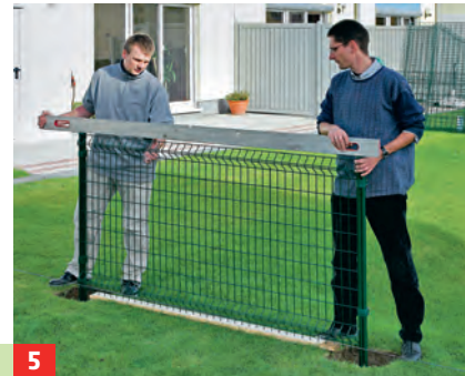
5 Etwa 10 cm Beton in die beiden ersten Löcher gießen, das Gitter mit den Pfosten einsetzen und ausrichten.
