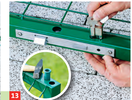
13 Einsteckschloss einführen und Schließzylinder montieren. Im Detail: Das Einschlagen der Scharnierhülse.
