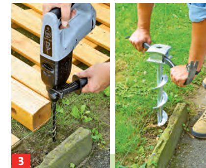
3 Als Führung für den Schraubanker* (rechts) mit einem 60-cm-Bohrer vorbohren, dann den Anker einschrauben.
