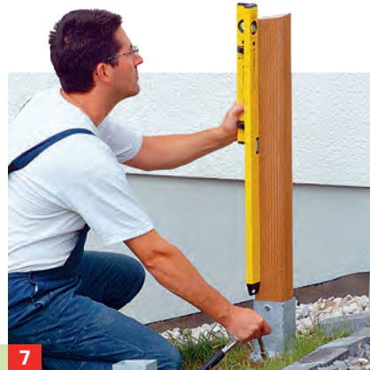
7 Richten Sie die Pfosten exakt waagrecht aus und verschrauben sie.
