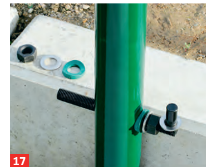
17 Torbänder und Distanzringe werden durch den Pfosten gesteckt und verschraubt.
