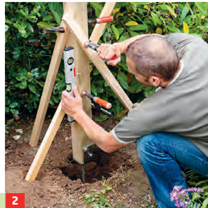
2 80-cm-Loch ausheben, Pfosten samt Schuh lotrecht darin platzieren und mit Latten und Zwingen fixieren.
