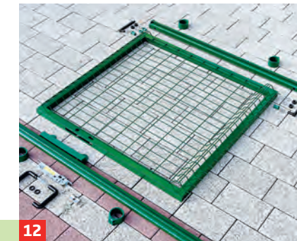
12 Es folgt das Gartentor. Hier die Einzelteile: Tor, Pfosten, Klinke, Scharniere, Schloss-Anschlag und Montagebügel.
