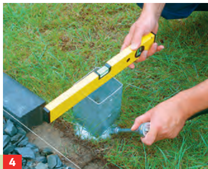
4 Kontrollieren Sie mit der Wasserwaage, ob die Bodenhülsen exakt sitzen; eventuell Korrekturen vornehmen.
