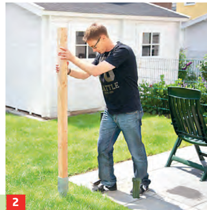
2 Zum Ausrichten der Hülse immer wieder Pfosten einsetzen. Am Ende alle Pfosten und Hülse verschrauben.
