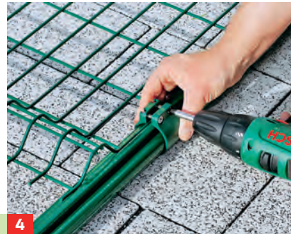
4 Die Gitter mit den Montagebügeln an den Pfosten befestigen. Passende Schrauben werden meist mitgeliefert.
