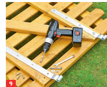
9 Am Tor die beiden Beschläge aus verzinktem Stahl festschrauben.
