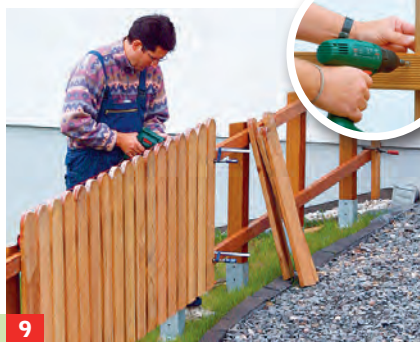
9 Es folgen die Zaunlatten, die man an den Querriegeln montiert. Übrigens: Verwenden Sie nur Edelschrauben!
