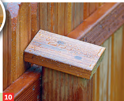
10 Die Pfosten wurden mit einer schrägen Abdeckung versehen, damit Regenwasser nicht eindringt und abtropft.
