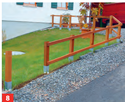
8 Anschließend die Querriegel an die Pfosten schrauben. Höhenverlauf vorher markieren und Löcher vorbohren.
