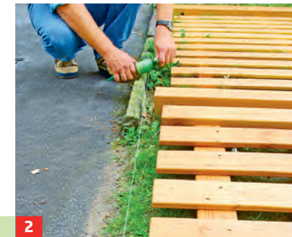
2 Am Anfang und Ende einen Pflock einschlagen und eine Richtschnur spannen, an der man den Zaun ausrichtet.
