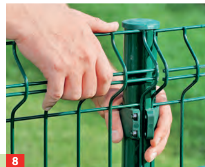
8 ... Elements befestigen. Gittermatte für Gittermatte wird so mit den Montageclips ganz einfach fixiert.
