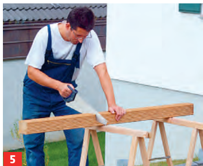
5 Nun ggf. die Zaunpfosten mit Fuchschwanz auf das gewünschte Maß ablängen. Böcke dienen als Auflage.
