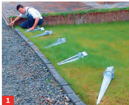
1 Erst eine Richtschnur für den wünschenswerten Zaunverlauf spannen und Einschlag-Bodenhülsen bereitlegen.
