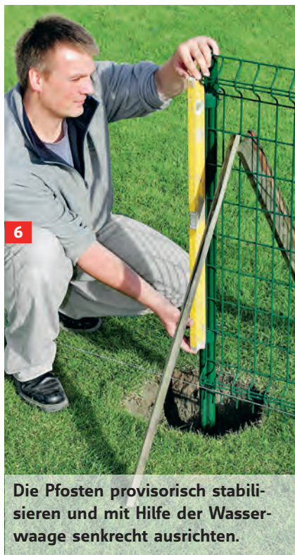
6 Die Pfosten provisorisch stabilisieren und mit Hilfe der Wasserwaage senkrecht ausrichten.
