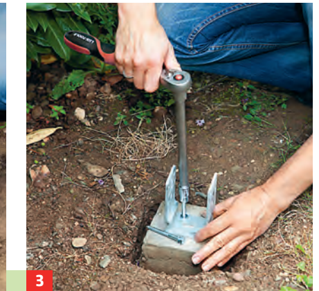
3 ... (hier: U-Schuh mit Wulst) aufsetzen, Löcher bohren, Nyldübel einschlagen und den Schuh festschrauben.
