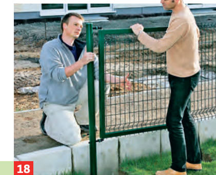
18 Nun das vorbereitete Gartentor einsetzen. Die Pfosten mussten in diesem Fall gekürzt werden.
