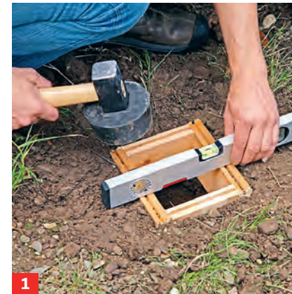
1 Loch ausheben, Holzschalung für den oberen Bereich des Fundaments einsetzen und waagrecht ausrichten.
