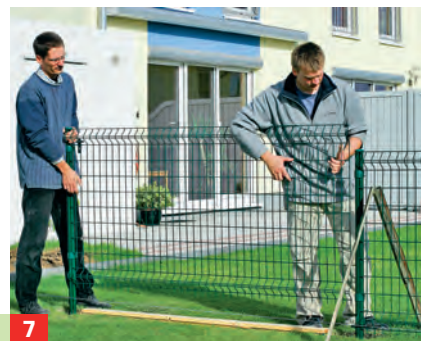
7 Dann Beton einfüllen. Der Richtschnur folgend das nächste Element an einem der beiden Pfosten des gesetzten ...
