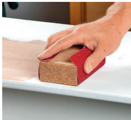
RICHTIG: Schleifklotz am besten längs zum Schleifpapier und zur Maserung führen.
