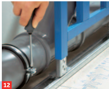
12 Die 110-mm-Rohre durch die Schellen führen und die Schrauben an den Schellen festziehen. Die HT-Rohre ...
