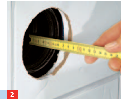
2 ... vorgegeben. Messen Sie nun den Abstand von der Fliesenoberseite bis zum Rohranschluss in der Wand.
