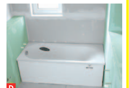
D Dann wird die Acrylwanne eingesetzt und angeschlossen. Wichtig: Stahlwannen vom Fachmann erden lassen!
