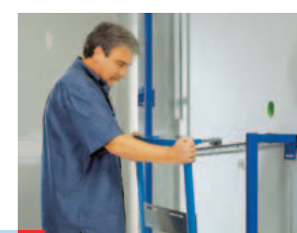
6 Um am Schornsteinschacht auf Wannenbreite zu kommen, befestigen wir hier ein deckenhohe Zusatzelement.
