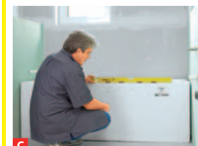
C Kleine Unebenheiten des Bodens können durch den Kleberauftrag ausgeglichen werden.
