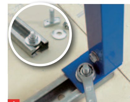
4 ... am Element, zur Wand und zum Boden hin festziehen. Unter die Mutter kommt eine Unterlegscheibe.
