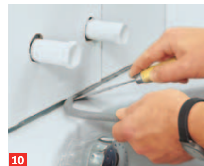
10 In die ausgekratzen Fugen mittels Schraubendreher eine Hinterfüllschnur aus Polyethylen drücken.
