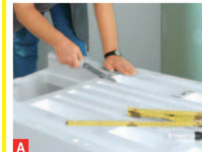
A Für den Abfluss und die Revisionsöffnung am Hartschaumwannenträger entsprechende Ausschnitte vornehmen.
