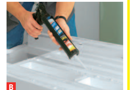
B Der Wannenträger wird dann auf den ebenen Untergrund geklebt. Dies erfolgt mit geeignetem Kleber für Hartschaum.
