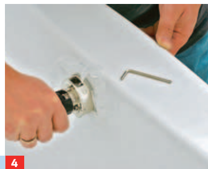
4 ... von der Wanneninnenseite einsetzen und die Hohlsschraube mit beiliegender Montagehilfe festziehen.
