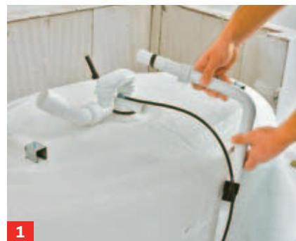
1 Wanne kopfüber auf den Boden legen und das Ablaufgehäuse montieren. Überlaufrohr anhalten, ggf. kürzen.
