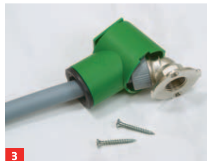
3 ... übers Rohr stülpen. Leitungsende in den Fitting stecken, der auf den Messingwinkel geschraubt ist.
