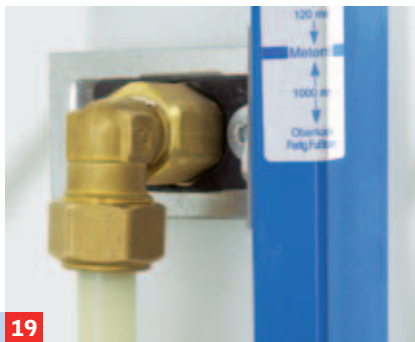
19 ... Gewinde wickeln. Die Kunststoff-leitung steckt man ins Winkelstück und zieht die Mutter fest.
