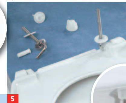
5 WC-Deckel-/Brille mit beiliegenden Haken und Muttern am WC verschrauben.
