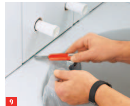
9 Nach dem Fliesenlegen folgt die Abdichtung. Zunächst die Mörtelreste aus den Anschlussfugen kratzen.
