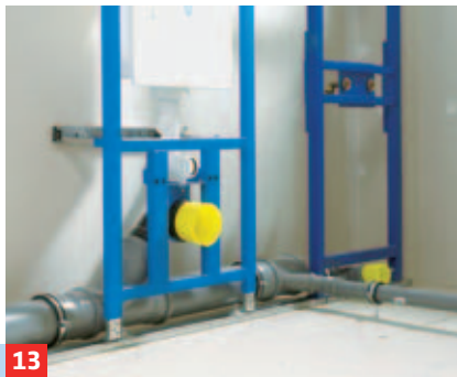
13 ... können einfach ineinandergesteckt werden, sie haben eine vormontierte Lippendichtung. Es folgen die ...
