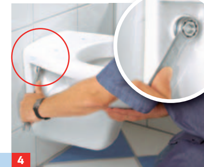
4 ... Rohre bei der Montage in die Wandanschlüsse einführen, WC mit Muttern an den Gewindestangen verschrauben.
