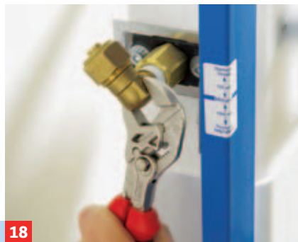
18 Seitlich am Spülkasten ein Winkelstück für den Wasserzulauf einschrauben. Auch hier Teflonband um das ...
