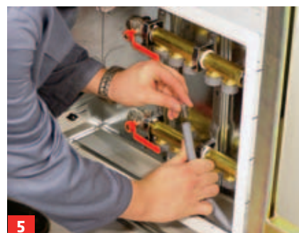
5 Am anderen Rohrende Richtung Verteiler ebenfalls die Edelstahlstützhülse einführen. Dann das Rohr ...
