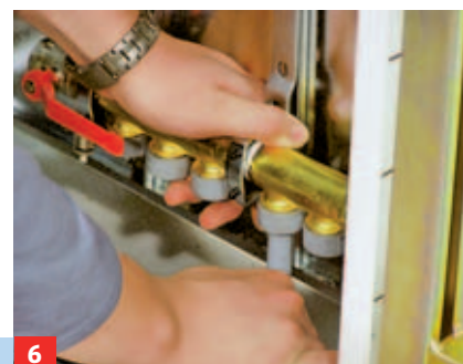
6 ... einfach kräftig in den Fitting am Verteiler schieben, bis zwei Druckpunkte überwunden sind.
