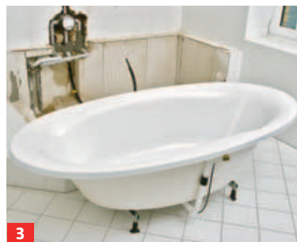
3 Die Wanne umdrehen und mittels Schraubenschlüssel an den Stellfüßen ausrichten. Das Überlaufgehäuse ...
