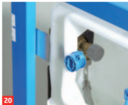
20 Unten rechts sieht man den bereits vormontierten Schlauch, der das Wasser in den Spülkasten leitet.
