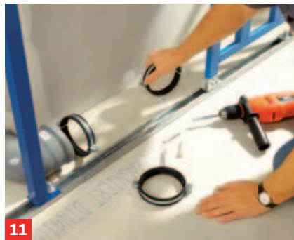
11 Es folgt die Verlegung der HT-Abwasserrohre. Zur Befestigung Schellen im Boden verschrauben.
