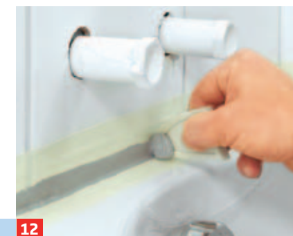
12 Silikon mit Spüli benetzen und mit Abziehkeil oder Finger und Haushaltshandschuhen bündig abziehen.
