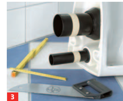
3 Abstände auf die Rohre übertragen, mit Kreppband markieren, die Rohre zusägen. Die am WC aufgesteckten ...
