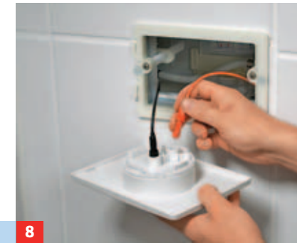
8 Die Betätigungsplatte mit den beiden Zügen verbinden. Farbige Markierungen erleichtern den Anschluss.
