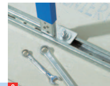
8 Anschließend ziehen Sie die Muttern an den Wand- und Bodenschienen mit einem Schlüssel fest.
