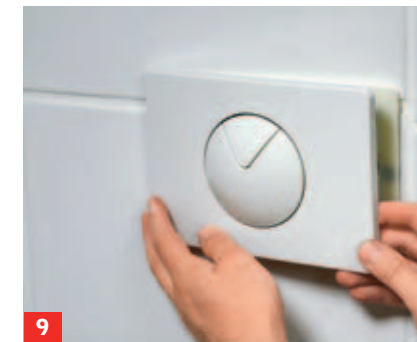
9 Anschließend wird die Betätigungsplatte seitlich aufgesteckt, bis sie hörbar einrastet.
