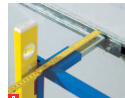
7 Das Modul unten in die Boden- und oben in die Wandschiene setzen und mittels Wasserwaage exakt ausrichten.
