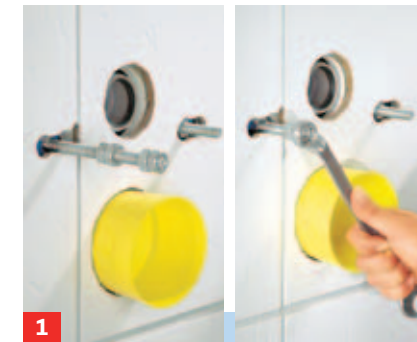
1 Überm Abfluss zwei Gewindestangen für die WC-Montage eindrehen*. Beim Vorwandmodul sind die Löcher ...
