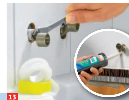
13 Zur Montage der Armatur Anschlussstücke in die Zuleitungen einschrauben. Rundum mit Silikon abdichten.
