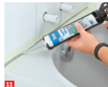
11 Dann die Anschlussfuge mit Silikon verschließen, ggf. vorher ober- und unterhalb mit Kreppband abkleben.
