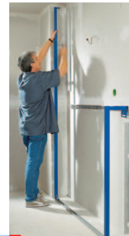
5 Zur Seite hin ggf. Wandwinkel montieren, damit man eine seitliche Beplankung festschrauben kann.
