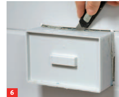
6 Falls vorhanden, Bauschutzdeckel über dem Spülkasten mit einem Cutter bündig zur Wand abschneiden.
