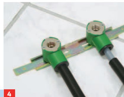
4 Die kompletten Anschlussdosen nun an einer Anschlussleiste bzw. an einem Vorwandssystem montieren.
