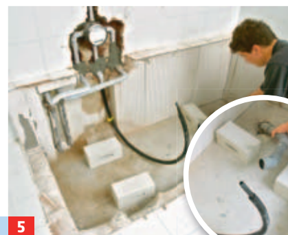
5 Montieren Sie nun ein entsprechend langes Ablaufrohr und ggf. längere Zuleitungen.
