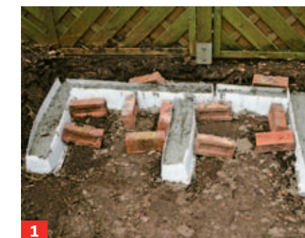
1 Boden für ein Streifenfundament ausheben. Bodenlose Blumenkästen dienen als Verschalung für den Beton.
