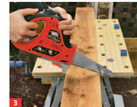
3 Schlagen Sie Alu-Profile ein und sägen die Bretter zu – sie müssen im Profil beidseitig noch Spiel haben.
