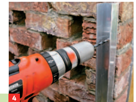
4 Lassen Sie alle Bretter in die Schiene gleiten und dübeln Sie die Profile anschließend fest.
