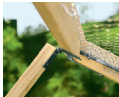
Die Stützen sind mit Scharnieren an den Rahmen geschraubt.
