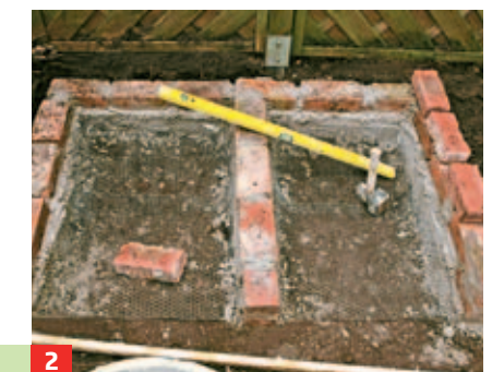
2 Unebenheiten ausgleichen. Die erste Steinreihe muss exakt in der Waage sein. Mauern Sie immer auf Lücke.
