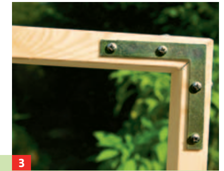
3 Verstärken Sie die Ecken mit Flachwinkeln, dann wird der Rahmen stabiler. Nehmen Sie kurze Schrauben.
