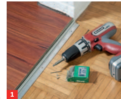
1 Ein Grund- bzw. Trägerprofil am Boden festschrauben, hier über einer Dehnungsfuge am Raumübergang.
