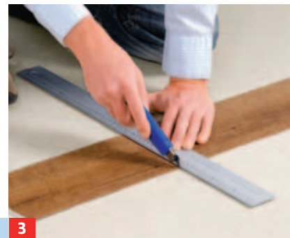
3 Nicht direkt auf Stoß an die Wand setzen. Oberfläche an der Schnittlinie anritzen, das Lineal dient als Anschlag.
