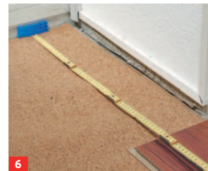
6 Das letzte Element der Reihe ggf. kürzen. Abstand unter Berücksichtigung der Dehnungsfuge ausmessen.
