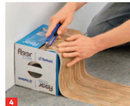
4 Die Bahn bis ans andere Raumende verkleben, dort die Box an die Wand schieben und die Bahn grob trennen.
