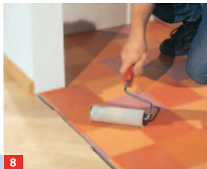
8 ... wegrollen und verkleben. Abschließend den Belag mit einer Rolle andrücken, so dass sich keine Beulen ...
