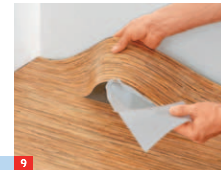
9 Den zugeschnittenen Streifen mit der Schnittkante zur Wand verkleben. Abschließend Sockelleisten montieren.
