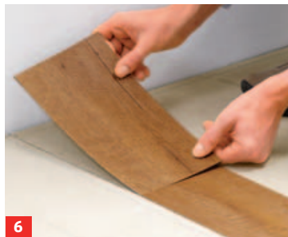
6 Legen Sie die Planke dann in einer Flucht dichtgestoßen an die bereits verlegte heran und drücken sie fest.
