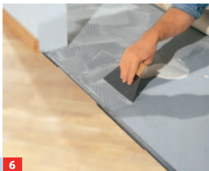
6 ... zwischen die Beläge setzen. Nach dem Zuschnitt den Boden wegrollen und mit Zahnkelle abschnittsweise ...
