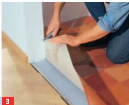
3 Den Überstand rechts und links der Zarge mit einem Cutter passgenau einschneiden. Zu den Wänden hin ...
