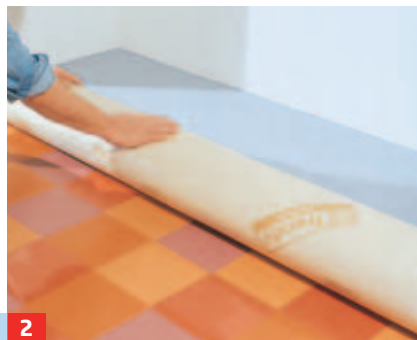
2 Ist entsprechend breite Ware gekauft, (ggf.) großzügig zuschneiden (plus 5 cm zu allen Seiten) und dann ausrollen.
