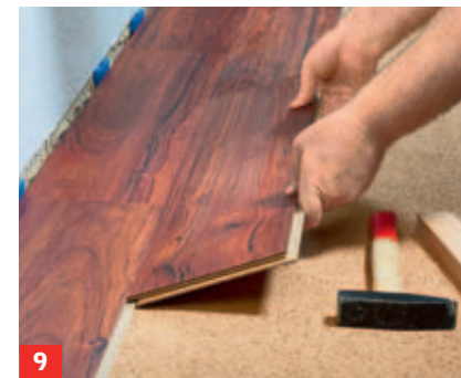
9 Hebeln Sie die Elemente erst längs-seitig schräg ein und fügen danach die Stirnseiten ineinander.
