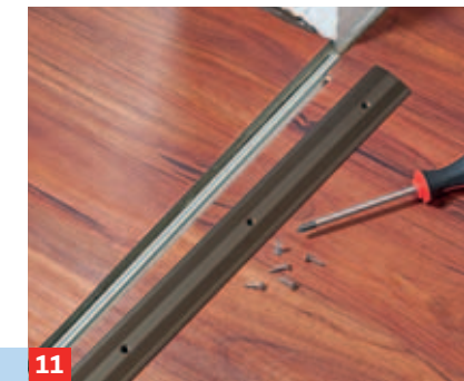
11 Den Boden bis wenige Millimeter ans Übergangsprofil heran legen, Abdeckleiste mit dem Träger verschrauben.
