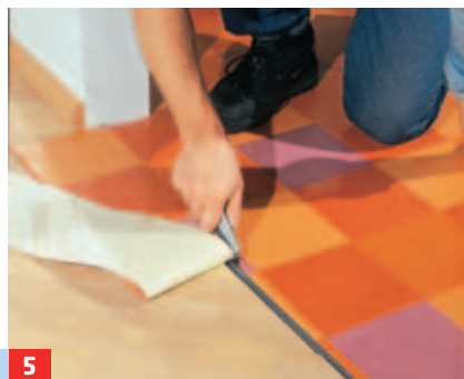
5 Überlappungen in Türdurchgängen bündig zum Belag im anderen Raum abtrennen und ein Übergangsprofil ...
