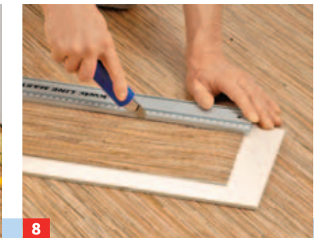
8 ... Schnittlinie auf den Belag zeichnen. Den Zuschnitt auf einer Schneidunterlage vornehmen, z.B. auf einem Brett.
