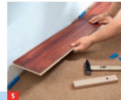
5 Nun das zweite Element und dann weitere Elemente der ersten Reihe stirnseitig schräg einhebeln.
