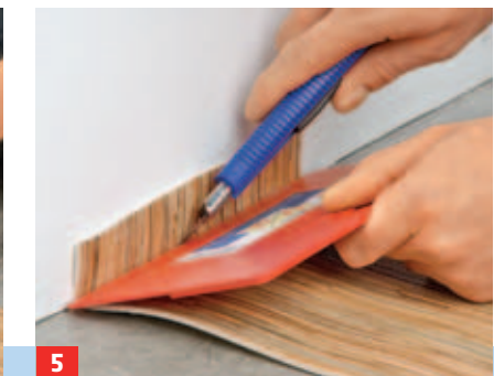
5 Dann die Bahn bündig zur Wand umknicken und abschneiden. Ein breiter Spachtel und ein Cutter helfen dabei.
