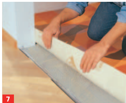
7 ... PVC-Bodenbelagskleber auftragen. Danach den Belag ausrollen und andrücken. Nun die andere Seite ...
