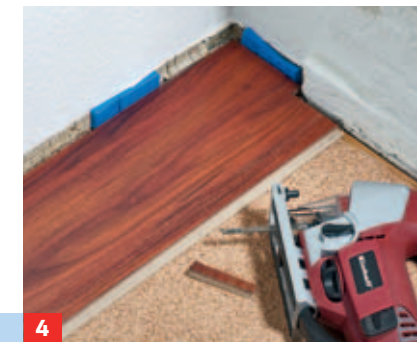
4 ... 15-mm-Dehnungsfugen. Ausschnitte an eventuellen Wandvorsprüngen mit der Stichsäge vornehmen.
