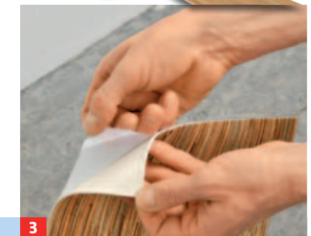
3 ... abrollen und währenddessen Stück für Stück die Schutzfolie abziehen. Die Bahn dann fluchtgerecht verkleben.
