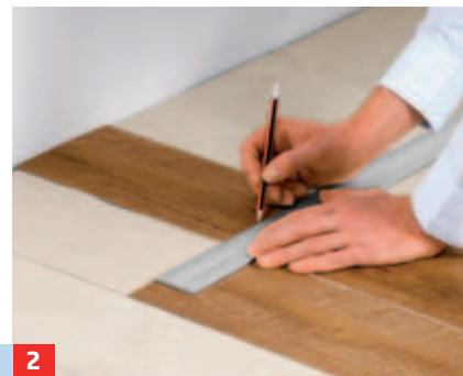
2 Dort beginnend die Planken verlegen. Am Reihenende eine Planke parallel anlegen und Abstand anzeichnen.
