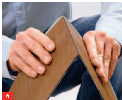
4 Hat man die 0,2 mm Nuttschicht durchgeschnitten, lässt sich die Planke einfach glatt durchbrechen.
