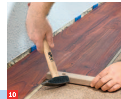
10 Vor allem hier helfen Hammer und Schlagklotz, die Elemente fugenlos zusammenzufügen.
