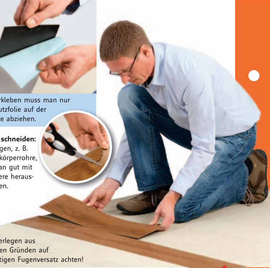
2 Dort beginnend die Planken verlegen. Am Reihenende eine Planke parallel anlegen und Abstand anzeichnen.
