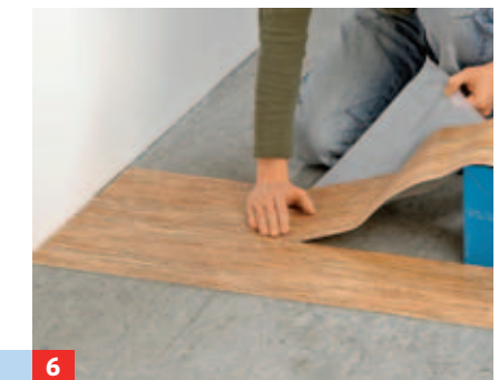
6 Eine andere Box nehmen (damit sich die Struktur unterscheidet!) und die nächste Bahn fugenlos verkleben.
