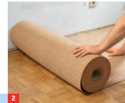
2 Das Vinylparkett hat eine Korkunterseite, eine separate Unterlage sorgt aber für zusätzlichen Trittschallschutz.
