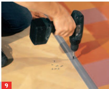
9 ... bilden. Je nach Profilart muss am Ende noch eine Abdeckleiste auf Grundprofil geschraubt werden.
