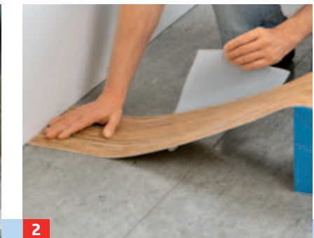
2 ... durch den Raum. An dieser Linie (oder eben an einer geraden Wand) die Verlegung beginnen: Boden ...
