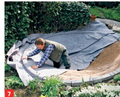
**7** Ein dickes Vlies schützt die Folie vor Schäden durch Steine und Wurzeln
