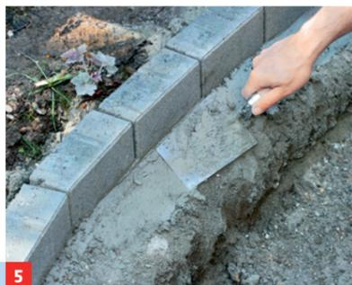
**5** Randeinfassung nivellieren und z. B. mit Betonsteinen einfassen
