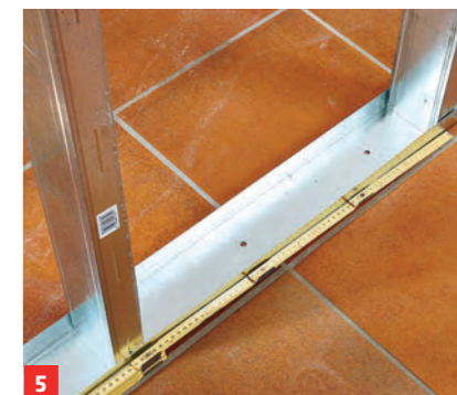
5 Die Ständerabstände auf die Plattengröße abstimmen, bei 125-cm-Platten quer montiert 62,5 cm!
