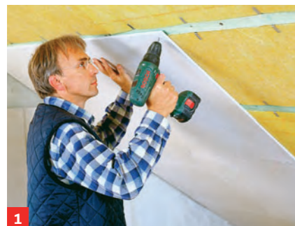
1 Bauplatten, hier Gipsfaserplatten, stets versetzt übereinander montieren. Beim Verschrauben ca. 5 mm ...
