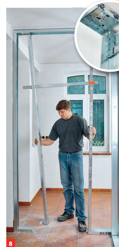
8 Oben und unten beidseitig Steckwinkel zur Stabilisierung einfügen, dann in die UW-Profile einstellen
