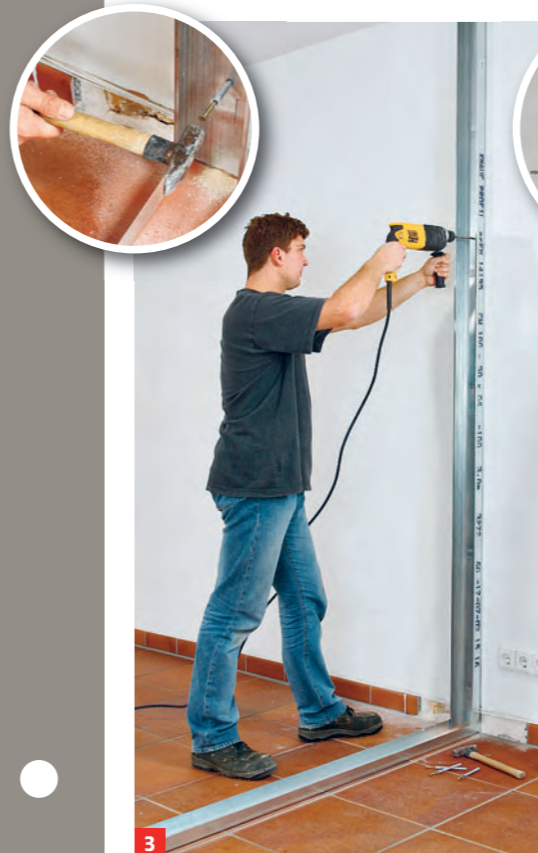
3 CW-Profil für den Wandanschluss ins UW-Bodenprofil einstellen und senkrecht an der Wand verdübeln
