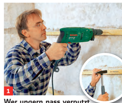
1 Wer ungern nass verputzt, nimmt Platten: Holzleisten horizontal verschrauben. Gipsplatten mit ...
