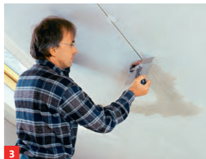
3 Die Fugen werden nach der Montage mit Fugenspachtel – am besten auf Gipsbasis – verschlossen
