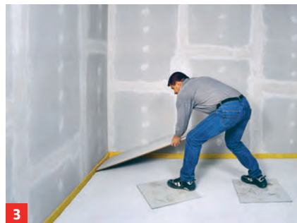
3 Abgezogene Schüttung nicht direkt betreten! Trockenestrich auflegen
