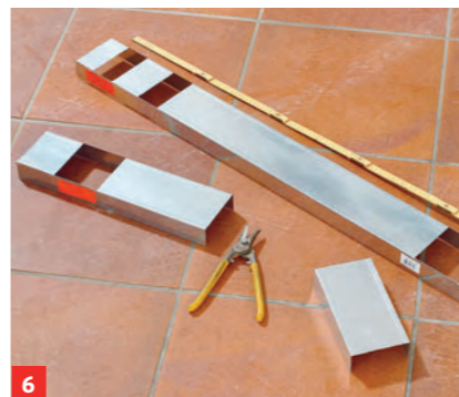
6 Das Türsturzprofil auf die gewünschte Türbreite zuschneiden. Praktisch: vorgestanzte Bauöffnungsmaße
