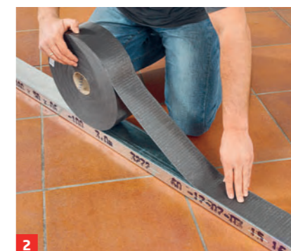
2 UW-Profile ggf. zuschneiden und rückseitig mit Dämmstreifen versehen. Dann am Boden verdübeln
