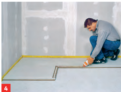
4 Meist werden die Elemente an der Stufenfalz miteinander verklebt
