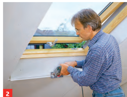
2 ... Fugen zwischen den Platten einplanen. Laibungsverkleidungen lassen sich leicht selbst herstellen
