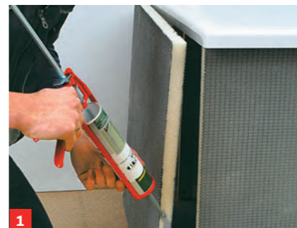
1 Mit zementummantelten Hartschaumplatten lassen sich gut Wannen verkleiden. Die Platten werden verklebt
