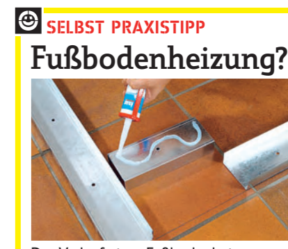
SELBST PRAXISTIPP Fußbodenheizung? Der Verlauf einer Fußbodenheizung lässt keine Verdübelung am Boden zu. Die UW-Profile dann fest verkleben.
