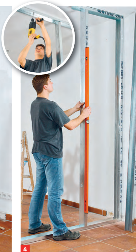
4 UW-Deckenprofil verschrauben, dann weitere CW-Profile einstellen, die in dieselbe Richtung zeigen sollten
