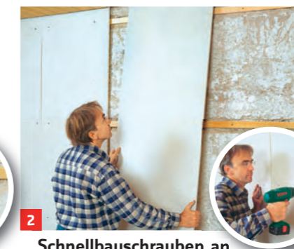
2 ... Schnellbauschrauben an den Leisten befestigen. Oder ohne Leisten mit Gipsbatzen an die ...
