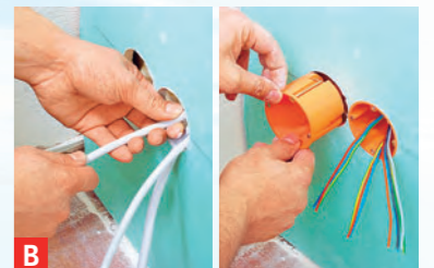
B Kabel hindurchziehen, äußeren Mantel mit Abisolierzange lösen und abstreifen, Adern durch die Dose führen und diese befestigen
