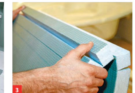
3 ... und direkt überfliesen. Schneidet man sie von einer Seite ein, kann man sogar Rundungen herstellen
