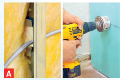
A Elektrische Leitungen durch die Löcher in den Profilen ziehen. Öffnungen für Schalter und Dosen mittels Lochsäge herstellen
