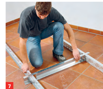
7 Das zugeschnittene Türsturzprofil von oben über zwei UA-Profile schieben und mit Kleband fixieren
