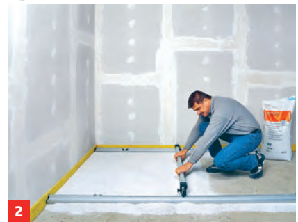
2 Bei Höhenunterschieden Schüttung einbringen und über Lehren abziehen
