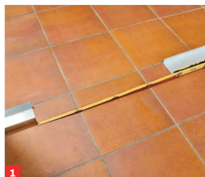
1 Wandverlauf am Boden markieren. Vorgesehene Türen berücksichtigen und Wandöffnungsbreite einplanen
