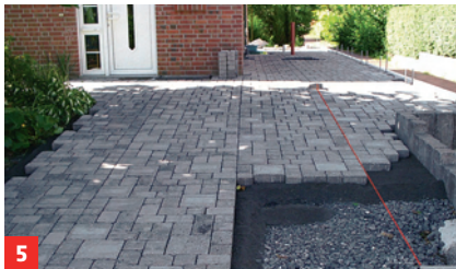
5 Eine Richtschnur dient als Orientierungshilfe. Die fertige Pflasterfläche ...
