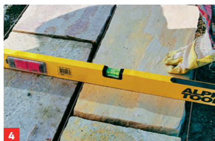
4 Die Steine entlang einer Richtschnur ins Mörtelbett setzen und mit dem ...
