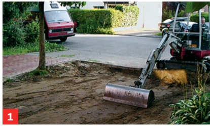
1 Das Erdreich wird hier ca. 20 cm tief abgetragen, verdichtet und zuerst ...
