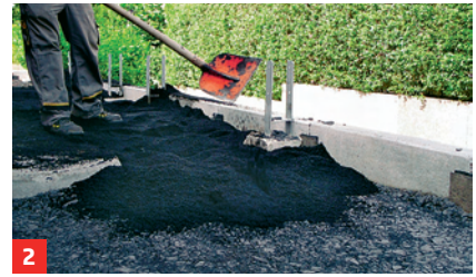
2 ... mit grobem, dann feinem Schotter oder Sand als Unterbau aufgefüllt
