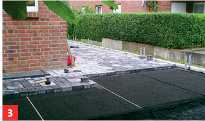
3 Mit dem Rüttler verdichten und abziehen (Praxistipp S. 6). Die Betonsteine ...
