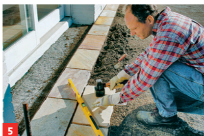
5 ... Gummihammer einschlagen. Überschüssigen Mörtel sofort entfernen
