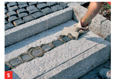
5 Herausquellenden Mörtel mit der Kelle entfernen, Rest mit dem Schwamm
