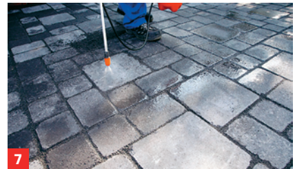
7 ... Verdichten nochmals mit Wasser und Sand/Splitt einschlämmen
