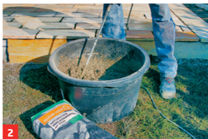
2 Naturstein-Verlegemörtel anmischen. Um die Haftung zwischen Untergrund ...
