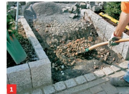
1 Im Bereich der Treppenstufen wird das Erdreich mit der Schaufel abgetragen
