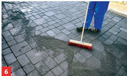
6 ... abrütteln. In die Fugen trockenen Sand oder Splitt einfeigen. Nach dem ...
