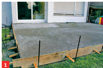
1 Voraussetzung für eine stabile Terrasse: ein fester Untergrund (Betonfundament)
