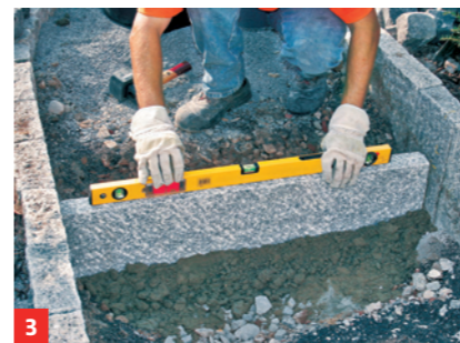
3 Die Stufen ins erdfuchte Mörtelbett setzen und lotrecht ausrichten
