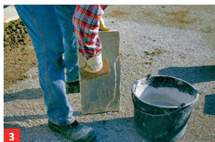
3 ... und Stein zu verbessern, den Stein mit Mörtelschlänme bestreichen
