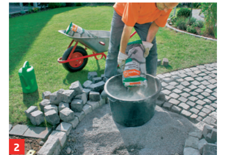
2 Naturstein-Verlegemörtel anmischen: größere Mengen mit dem Quirl
