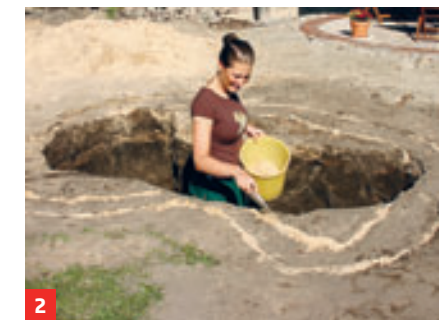
2 Zuerst den tiefsten Teichbereich ausheben, dann Flachwasserzonen
