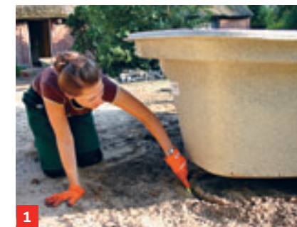
1 Kontur des Beckens übertragen, für Außenkontur Richtlatte verwenden
