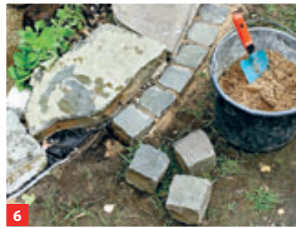
6 Nach Verlegen der Teichfolie Rand am besten mit Steinen kaschieren
