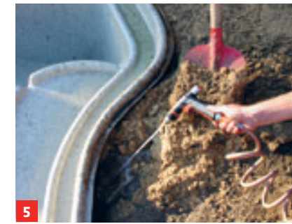
5 Schließlich Form mit Sand einschlämmen, um die Wasserlast abzufangen
