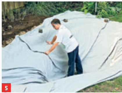
5 ... gegen Beschädigungen der Teichfolie einbringen und glätten
