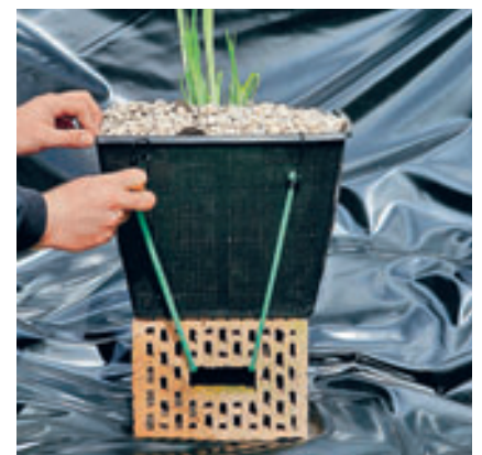
UNTER WASSER Pflanzkübel vor dem Fluten des Teichs gegen Aufschwimmen sichern
