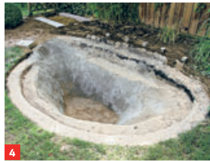
4 Teichform begradigen, Steine entfernen, danach Schutzvlies ...
