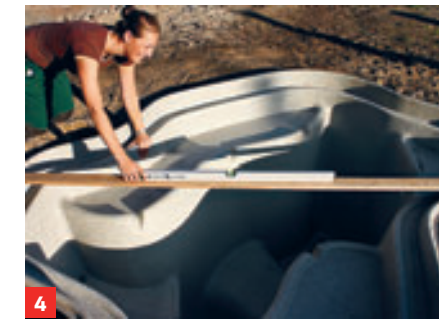
4 Becken exakt waagrecht einbauen, damit später die Wasserlinie stimmt
