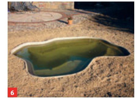
6 Dabei das Becken nach und nach mit Wasser füllen, dann setzen lassen
