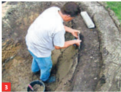
3 Teichzonen modellieren, dabei Flachwasserzonen am Rand befestigen
