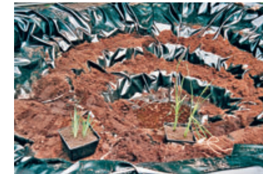
TERRASSENFORMIG werden die Teichzonen bei der Anlage des Teichs in die Teichfolie eingearbeitet. Mit Kies verschiedener Körnung wird die Beckenform etwas fixiert
