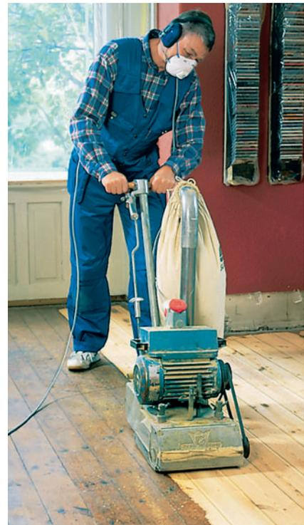
**MIT DER WALZENSCHLEIFMASCHINE** (Verleihgebühr, ca. 60 Euro/Tag) können Sie Bodenflächen abschleifen
