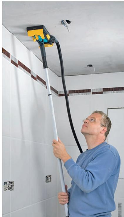
**MIT TELESKOPSTIEL** können Schleifarbeiten über Kopf von Hand erledigt werden – hier mit Absaug-Anschluss
