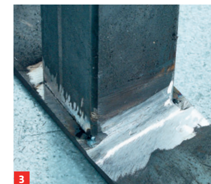
3 Nach dem Abkühlen die Schweiß-nähte mit Schruppscheibe polieren
