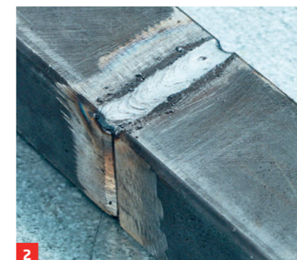
2 ... bei Bedarf ausrichten und danach durchschweißen. Nach dem ...
