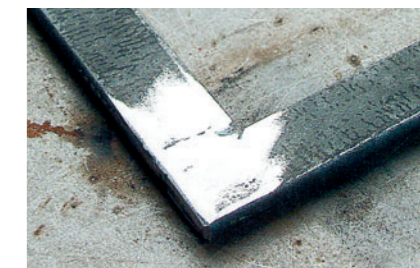
Dünne Rost- und Korrosionsschutz-Schichten können verschweißt werden – die Rauchgasbelastung ist dabei jedoch deutlich höher
