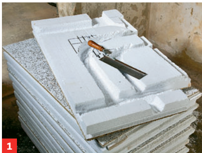
Rohrverläufe auf die Dämmplatten übertragen und ausschneiden
