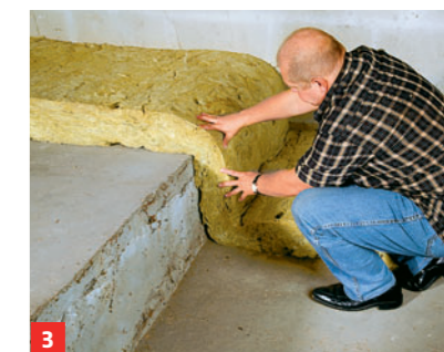
3 Die flexiblen Matten überdecken auch Stufen, müssen aber stets dicht anliegen
