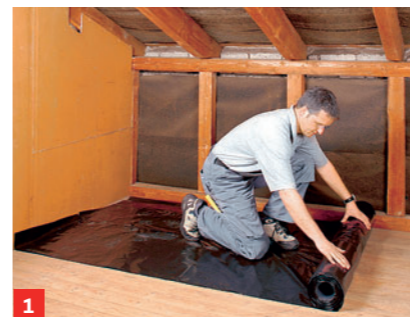
1 Vorm Verlegen von Verbundelementen auf Holzbalkendecke PE-Folie ausrollen
