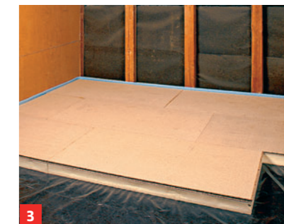
3 ... mit Leim an Nut und Feder ineinanderschleiben; Kreuzfugen vermeiden
