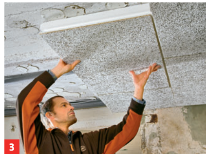
Die Platten greifen mit Nut und Feder ineinander; im Verbund verlegen!
