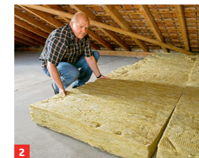
2 Die einzelnen Bahnen dicht zusammenschieben, die Stöße verfilzen so
