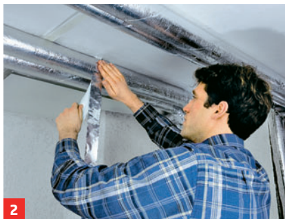
Schutzfolie abziehen und die Rohrschale mit integriertem Klebeband ...
