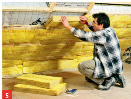
5 Lattung montieren, Untersparrendämmung einklemmen (max. 20% der ...
