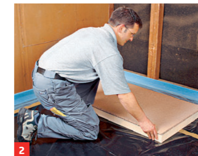
2 Dämmelement mit Federseite zur Wand auslegen, weitere Elemente ...
