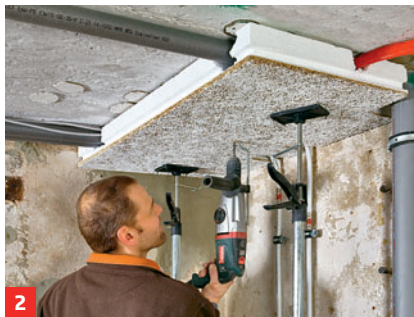
Dann die Platten an die Decke setzen und mit Betonschrauben befestigen
