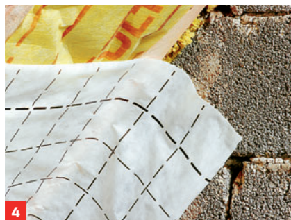
4 Die Giebelanschlüsse mit Kartuschenkleber und Anpressplatte ausführen
