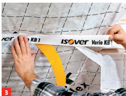
3 Tackereinstiche und einzelne Bahnen untereinander luftdicht verkleben
