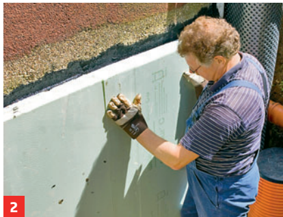
... Bitumenbatzen auf der Abdichtung verkleben. Neben einer Drainage am ...
