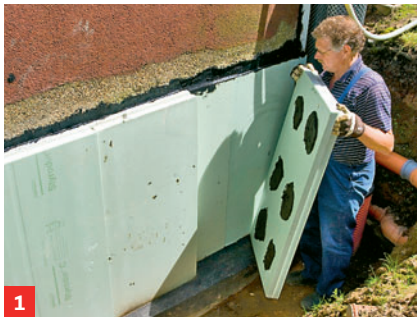
Beheizte Keller von außen dämmen! Wasserfeste Dämmplatten mit ...
