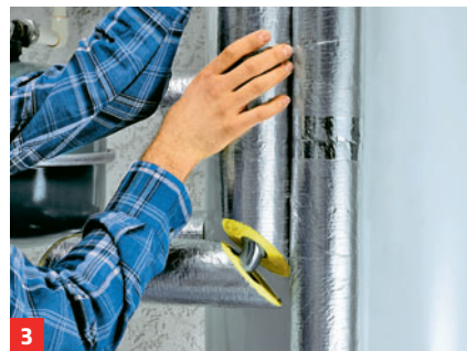
... verkleben. An Rohrbiegungen die Schalen auf Gehrung schneiden
