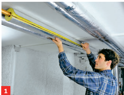
Rohrschalen aus Glaswolle oder Hartschaum einfach übers Rohr stülpen
