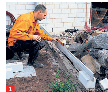
1 Tragen Sie eine satte Schicht Mörtel auf das Streifenfundament auf, setzen den ersten Stein und richten ihn aus
