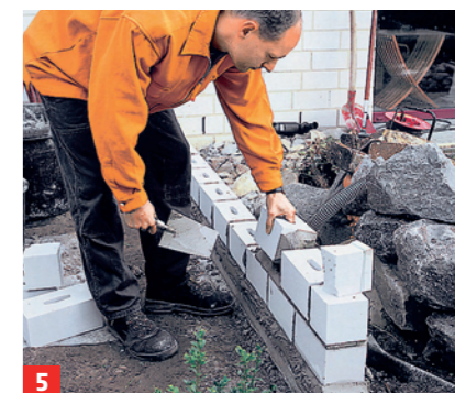
5 Zum anderen kommt Mörtel auf die Oberseite einer Steinschicht (Lagerfuge). Hier: Läufer-Halbstein-Verband
