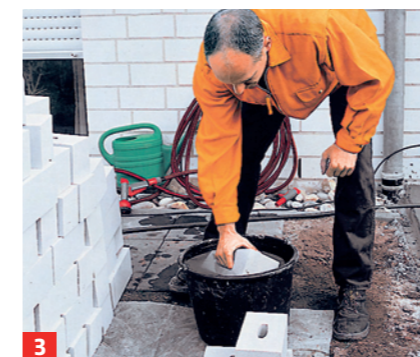
3 ... sonst wird die Mauer schief. Für eine gute Verbindung von Mörtel und Steinschicht die Steine vornässen
