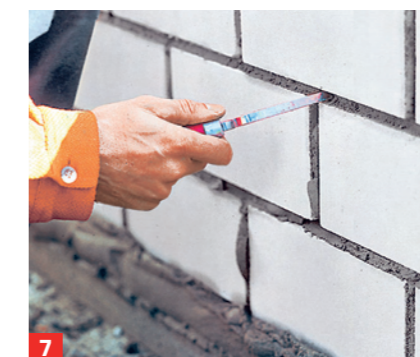
7 Direkt nach Fertigstellung der Mauer wird der Mörtel mit einem Fugeisen etwa 15 mm tief ausgekratzt
