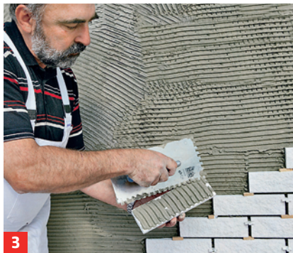
3 Die Verarbeitung erfolgt im Buttering-Floating-Verfahren, also auch auf der Riemchenrückseite Kleber auftragen
