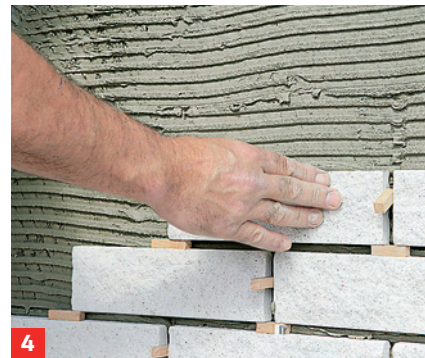
4 Zugeschnittene Holzklötzchen helfen, den Fugenabstand einzuhalten: Lagerfuge ca. 12 mm, Stoßfuge ca. 10 mm
