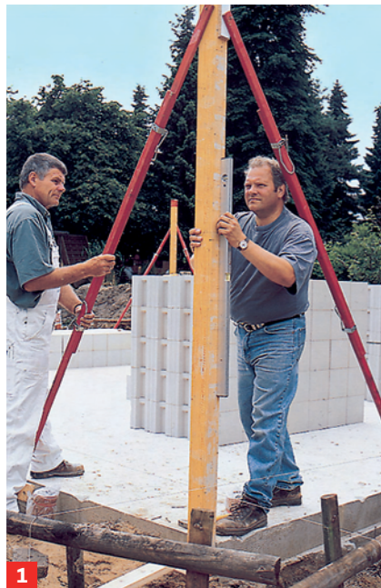
1 Zunächst die Mauerflucht ermitteln. Dies erfolgt mit Nivelliergerät und Richtlatte. Eckpunkte festlegen und ...
