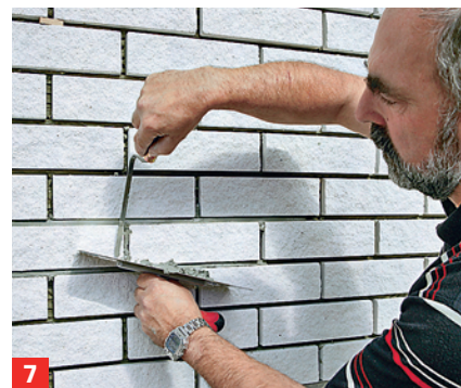
7 Achten Sie darauf, die Fugen so auszuformen, dass sich kein Regenwasser darin sammeln kann
