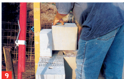
9 Um ausreichenden Fugenversatz zu erhalten, müssen manche Steine vor der Verarbeitung halbiert werden
