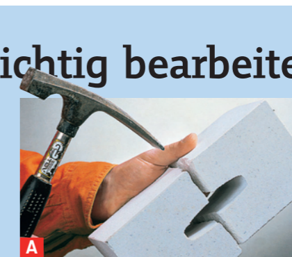
A Kalksandsteine mit dem Maurerhammer teilen, einfach rundum dagegenklopfen
