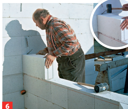
6 Um ein Abreißen der Innenwand zu vermeiden, in jeder zweiten Steinschicht Maueranker in der Außenwand einbinden
