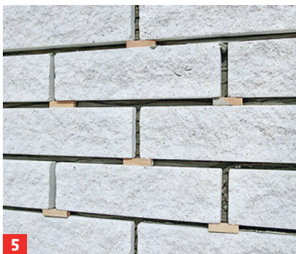
5 Hat der Kleber soweit abgebunden, dass die Riemchen fest sitzen, entfernen Sie die Klötzchen mittels Zange
