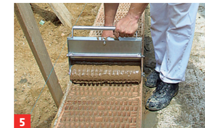
5 Angerührten Dünnbettmörtel in den Mörtelschlitten füllen und auf die Lagerfuge der Planziegel auftragen
