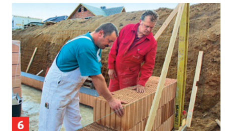
6 Die Fluchtschnur nach jeder Steinschicht nach oben versetzen, um sich an ihr orientieren zu können
