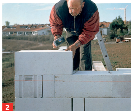
2 ... die Oberseite auf ein einheitliches Niveau schleifen – sehr praktisch. Stets auf das nötige Überbindemaß achten!
