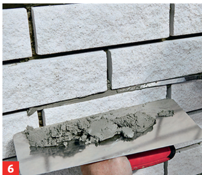
6 Mit einem Fugeisen bringen Sie den Fugenmörtel ein. Durch Drücken verdichten und die Fuge glatt abziehen
