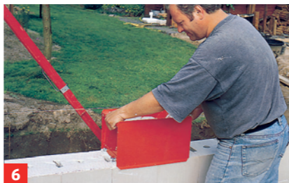
6 Den Mörtel mit Zahnkelle oder – besonders einfach und gleichmäßig – Mörtelschlitten auf die Lagerfuge aufbringen
