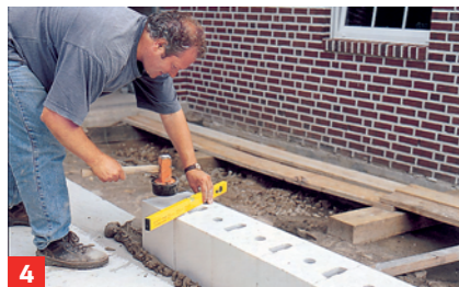
4 ... der Stoßfugen ist dank Nut und Feder überflüssig. Die Steine exakt im Mörtelbett ausrichten, die Schicht ...
