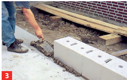
3 ... auftragen. Dann Normalmörtel satt aufbringen und die erste Steinschicht darin einsetzen. Eine Vermörtelung ...
