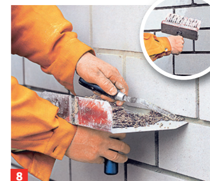
8 Reinigen und nassen Sie die Mauer zunächst, dann wird wie oben rechts skizziert verputzt
