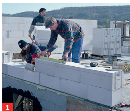
1 Porenbeton wird mit Dünnbettmörtel aufgemauert. Läuft eine Steinschicht einmal aus der Flucht, kann man ...
