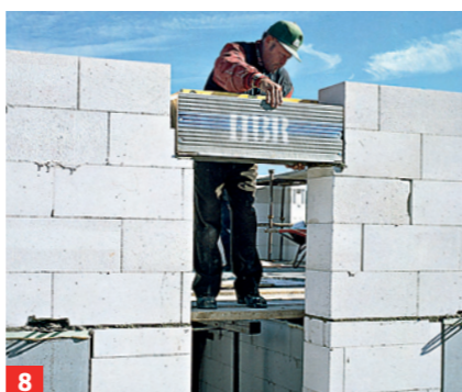
8 Neben Plansteinen fürs Mauerwerk stehen Sonderteile wie Stürze und Rollladenkästen zur Verfügung
