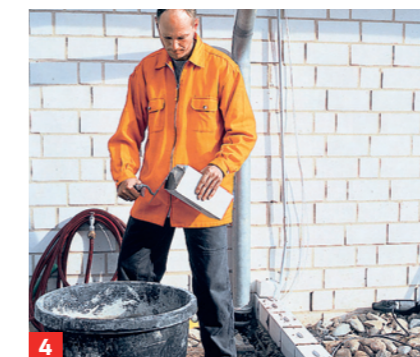
4 Die Kalksandsteine werden vollfugig vermauert, Mörtel kommt also zum einen auf die Steinköpfe (Stoßfuge)
