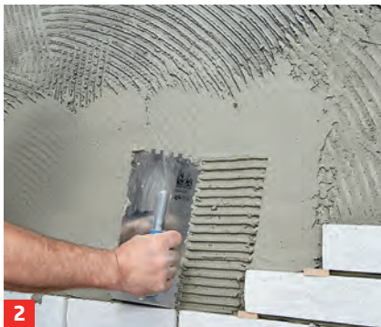
2 ... aufrauen und durchtrocknen lassen. Zur Verlegung Flexkleber verwenden, den Sie horizontal durchkämmen
