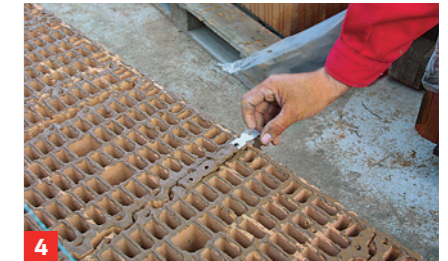
4 In jeder zweiten Ziegelreihe dort, wo später Innenwände anschließen, Mauerverbinder/-anker einlegen
