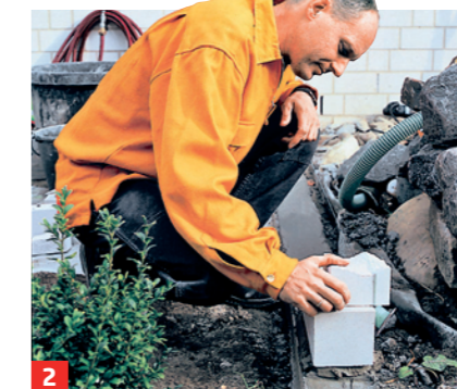
2 Eine Richtschnur spannen, an der entlang Sie die Steine mauern können. Die erste Steinlage lotrecht setzen, ...
