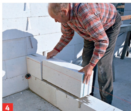
4 Um die Mauerflucht besser einzuhalten, Richtschnur spannen und bei jeder Steinschicht nach oben versetzen
