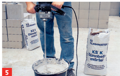
5 ... muss ein einheitliches Höhenniveau aufweisen. Zum weiteren Aufmauern der Plansteine Dünnbettmörtel anrühren
