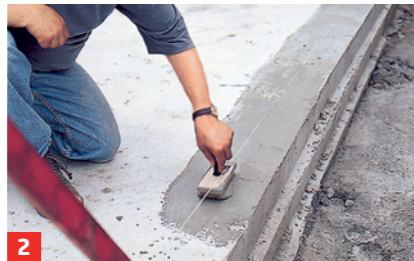
2 ... dazwischen Schnüre im Mauerverlauf spannen. In diesem Verlauf Dichtungsschlämme auf die Fundamentplatte ...
