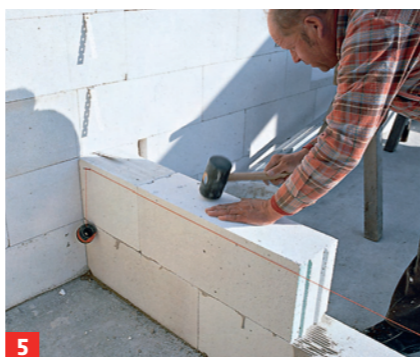
5 Die Plansteine greifen an der Stoßfuge mit Nut und Feder ineinander – leichtes Anklopfen genügt
