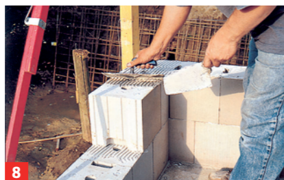
8 In Ecken oder an schwer zugänglichen Stellen den Mörtel mit der Kelle auftragen, bei Dünnbettmörtel ca. 2 mm
