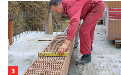
3 ... ausgerichtet werden kann. Block- und Planziegel greifen an der Stoßfuge mit Nut und Feder ineinander
