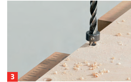
3 Zentrierspitze des Holzbohrers exakt aufsetzen und Bohrung ausführen
