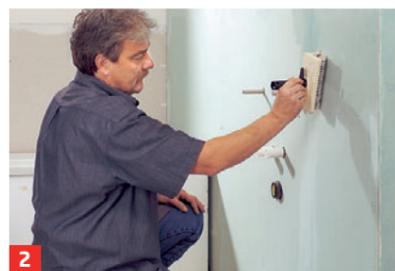
**1 WAND VERKLEIDEN** Feuchtraumplatten mit Gipsbatzen ansetzen oder an eine Lattung/Vorwandinstallation schrauben; Fugen verspachteln, Platten grundieren
