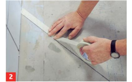
**2** ... die Fliesen trocken auslegt, die Diagonale markiert und entlang dieser abklebt
