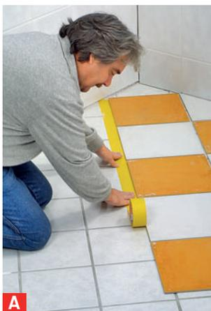
**A** Fliesen trocken auslegen, ggf. schon Zuschnitte vornehmen und den Verlauf mit Klebeband markieren
