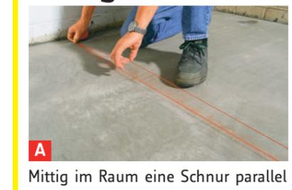
**A** Mittig im Raum eine Schnur parallel zur Wand spannen, Verlauf markieren
