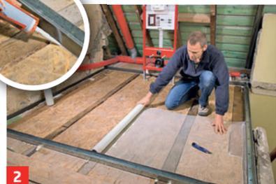
**1 BODEN GLÄTTEN** Vor allem der Boden muss eben sein, damit die Fliesen nicht brechen. Dies gelingt mit feuchtraumgeeignetem Trockenestrich **1** oder einer Ausgleichsmasse **3**. Hier ggf. Fugen verschließen und Gewebe auflegen **2**
