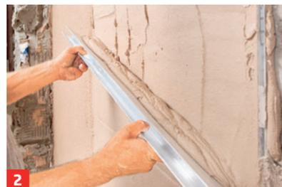
**1 WAND VERPUTZEN** Freihändig mit der Kelle gelingt das nur Profis. Besser bringen Sie Putzleisten an und ziehen aufgetragenen Putz darüber bündig ab
