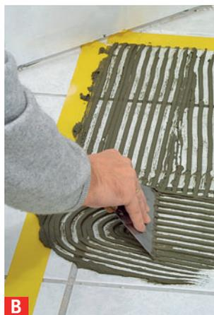
**B** Untergrund reinigen und abschnittsweise flexiblen, also kunststoffvergüteten Fliesenkleber auftragen
