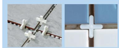
Fliesenkreuze sorgen für gleichmäßige Fugenverläufe – aber nur bei Fliesen mit gleichmäßig verlaufenden Kanten. Statt sie flach in den Kleber zu drücken (Bild rechts), wo sie dann verbleiben, kann man sie auch hochkant hineinstecken (links) und dann wiederverwenden.
