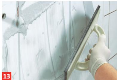
**13** Den Fugenmörtel mit Fuggummi oder Fugbrett in die Fugen einbringen
