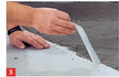
**3** Auf einem Abschnitt Fliesenkleber auftragen und das Kreppband abziehen
