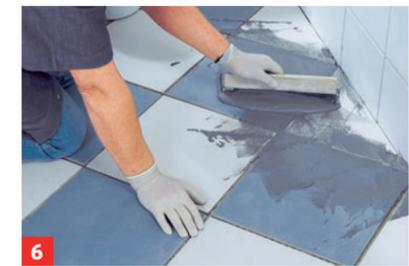
**6** Nach dem Verlegen den Fugenmörtel mit Fuggummi/Schieber einschlämmen
