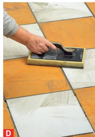
**D** ... müssen fest sitzen und eine ebene Fläche bilden! Die Verfugung erfolgt mit flexiblem Fugenmörtel
