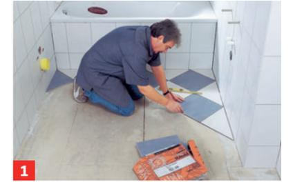
**1** Zur Diagonalverlegung mittig im Raum eine Linie zeichnen, von der aus man ...
