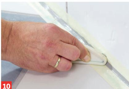
**10** Mit einem in Spüli getauchten Gummi- keil das Silikon abziehen, Band entfernen
