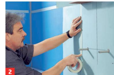
**2** Entlang den Linien Kreppband kleben (nach dem Kleberauftrag entfernen!)
