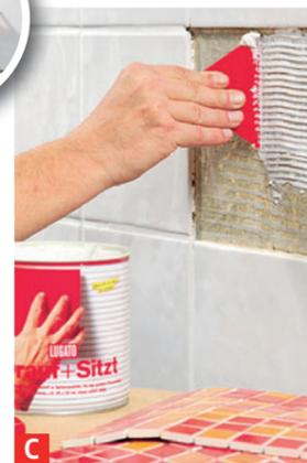
**C** Untergrund glätten und reinigen, dann Fliesenkleber auftragen. Praktisch: Dispersionskleber aus ...
