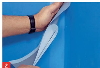
**1 ABDICHTEN** Im Spritzwasserbereich den Untergrund mit einem Abdichtanstrich **1** versehen. In den frischen Anstrich auf Anschlussfugen/in Ecken Abdichtbänder **2**, um Rohrgänge Dichtmanschetten **3** einlegen und überstreichen
