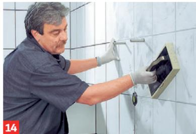
**14** Mit dem Schwammbrett nachfugen, mit einem Schwamm reinigen
