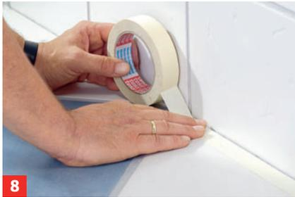
**8** Anschlussfugen mit Silikon abdichten. Für einen geraden Fugenverlauf die ...
