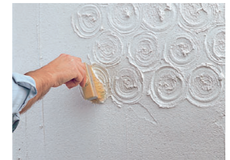
Sogenannte WASCHELRINGE erzielt man mit dem Malerpinsel bzw. Quast
