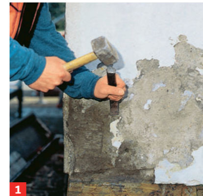
1 Hohlstellen der alten Putzfläche mit Hammer und Meißel abschlagen und bis auf den tragenden Grund säubern
