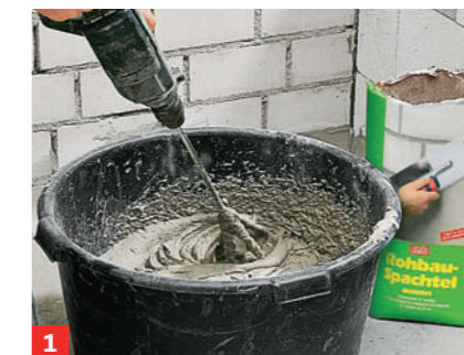
1 Als Unterputze stehen Trockenmörtel zur Verfügung, die Sie nach Herstellerangaben mit Wasser anmischen
