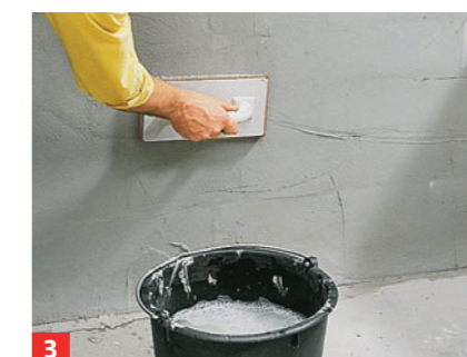
3 Nach 30 bis 90 Minuten reiben Sie den Putz mit einem angefeuchteten Schwammbrett glatt
