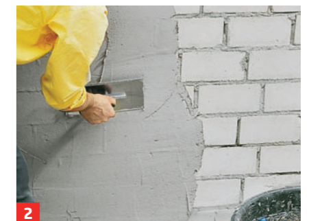
2 Mit der Maurerkelle den Putz aus dem Kübel holen, auf die Glättkelle geben und auftragen
