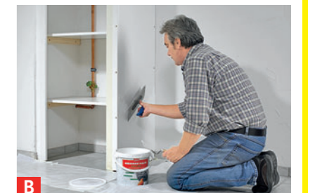
... mit Rolle oder Kelle auftragen. Wichtig: Nur beschichtete Spanplatten verputzen, rohe saugen zu stark
