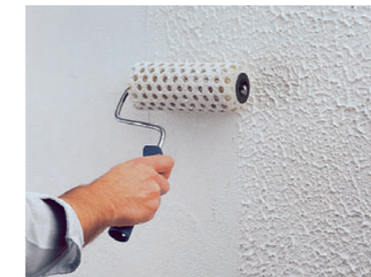
Die Erbslochwalze sorgt für eine RAUPUTZ- bzw. RAUFASERSTRUKTUR
