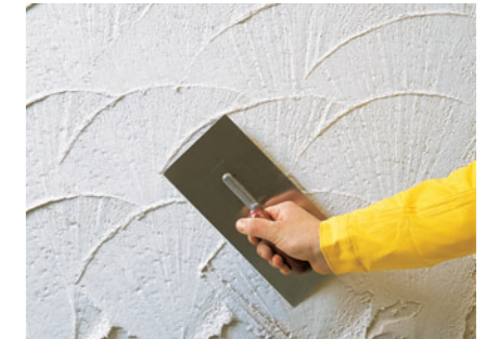
... Sie mit dem Malerspachtel, SCHUPPENSTRUKTUREN mit einer Glättkelle
