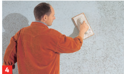
4 Nach ca. 15 Min. Putz mit Schwamm- oder Moosgummibrett abreiben
