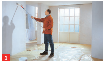
1 Sehr stark saugende Untergründe (z. B. Gipsputz, Porenbeton) erst grundieren
