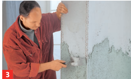
3 An Wandecken Eckschienen anbringen, die den Putz vor Stößen schützen
