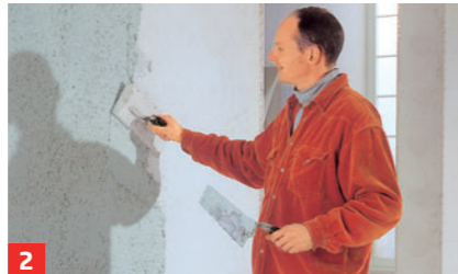
2 Putz mit schräg gestellter Glättkelle in Kornstärke abschnittsweise aufziehen
