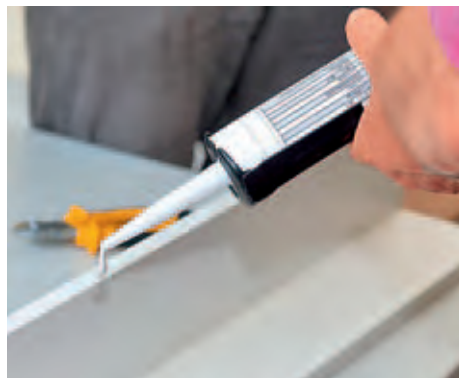
NACHLAUF: Ärgerlich, wenn in Arbeitspausen Dichtstoff ausläuft.
