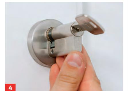
**4** **... Schließbart in die senkrechte Position bringen – alten Zylinder herausziehen, neuen einbauen**
