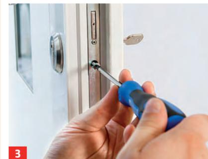
**3** **Nun die Stulpschraube lösen, die den Zylinder im Einsteckschloss fixiert. Durch ein Drittel Schlüsselrotation ...**
