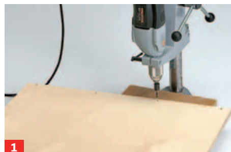
1 Die Seitenwände nach dem Zuschnitt an der hinteren Kante bohren und senken.
