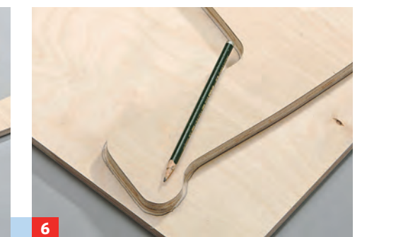
6 ... Seitenteil als Schablone für die folgenden Elemente verwendet wird. Die Konturen auf die nächste Platte übertragen.
