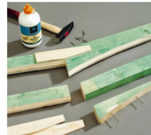
**4** ... für die Fixierplättchen finden Sie in unserem Bauplan. Die Plättchen für den Kopfring werden wegen des kleineren Durchmessers angeschrägt. Schneiden Sie sie aus und leimen Sie sie an den Ecken auf
