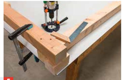
**5** ... die Bohrlöcher. Richten Sie die Balken rechtwinklig aus. Dann durchbohren Sie den oberen Balken bis in den unteren hinein.
