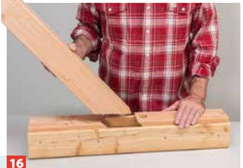
Die Bohrschablone ist fertig und kann nun verwendet werden. Hierzu werden die Diagonalstreben mit einem Ende eingesteckt.
