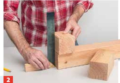
**2** ... Längen der Stützen! Bei der Unterkonstruktion werden die Querträger mit den Stützen verschraubt. Markieren Sie die Lage ...
