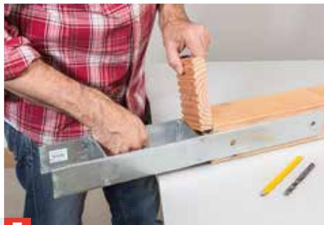
**7** Am unteren Ende der Stützen markieren Sie die Bohrungen für die H-Bodenanker. Wir haben überall eine Dielenstärke Luft ...
