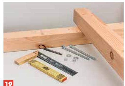
Nun können die einzelnen Bauteile probeweise montiert werden: Zunächst die Stützen mit den Querträgern verschrauben.
