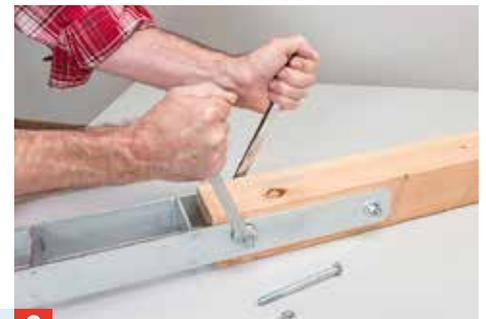
**8** ... zwischen Querstrebe und Balkenende gelassen. Nach dem Bohren werden die Anker mit Sechskantschrauben (vor Ort) befestigt.
