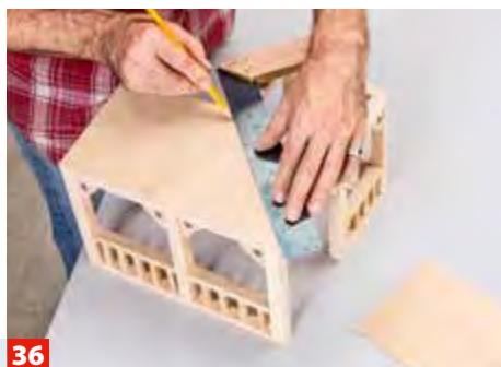
36 Dann werden die Sperrholz-Dachflächen eingepasst, zugeschnitten und aufgeklebt.
