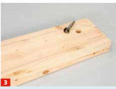
Zum einfacheren Ausschneiden durchbohren Sie die Platten an den Innenecken der beiden Rahmen.
