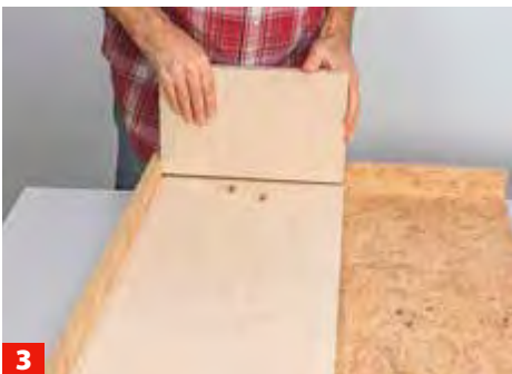
3 Mit 8-mm-Dübel-Markierspitzen übertragen Sie die Bohrlochpositionen in einer Winkellade auf die Seitenwände. Auch ...
