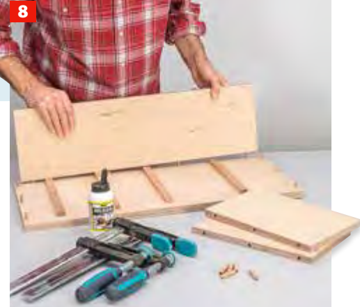
Legen Sie eine Seite auf die Arbeitsfläche. Dann die Rückwand, Deckel und Boden und schließlich die zweite Seite bekleben und mit Dübeln aufstecken.
