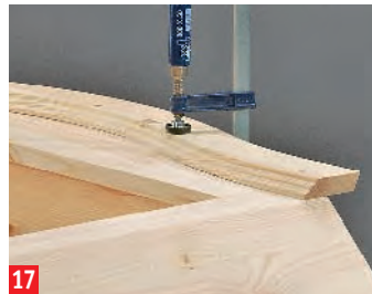
17 Verleimen und verschrauben Sie die unterste Kranzleiste. In den Zwischenräumen mit Zwingen pressen
