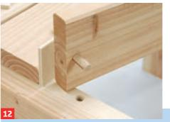
Distanzplättchen übertragen und mit Konstruktionsklebstoff wasserfest verkleben
