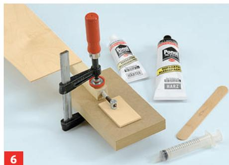
**6** 2-Komponenten-Klebstoff in das Bohrloch der Vierkantleisten geben und Schrauben möglichst gerade einsetzen
