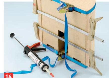
**14** ... verkleben, anschließend Sperrholzdach mit Übermaß aufkleben. Die Überstände nach Trocknung des Klebers abschleifen
