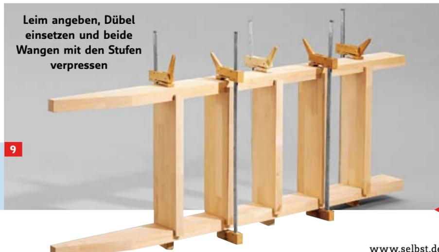
**9** Leim angeben, Dübel einsetzen und beide Wangen mit den Stufen verpressen
