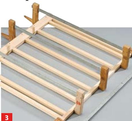
**3** Die äußeren Sparren sind im Kopf der Fußpfette verdübelt. PU-Klebstoff angeben, Dübel einsetzen und verpressen
