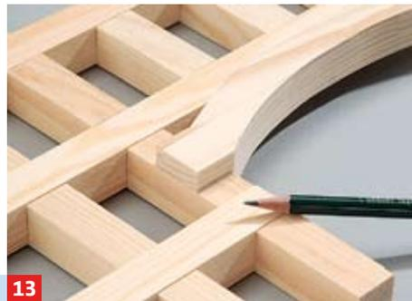
**13** ... stationären Stich- oder Dekupiersäge. Bauteil schleifen und Überblattung auf dem Ständer anzeichnen und ausarbeiten
