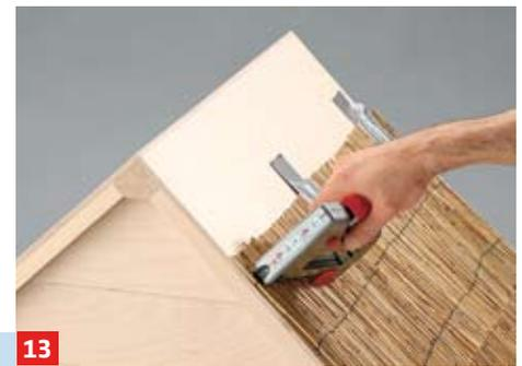
**13** Schilfrohmatten zuschneiden und in drei Lagen je Dachfläche überlappend mit Edelstahlklammern ...
