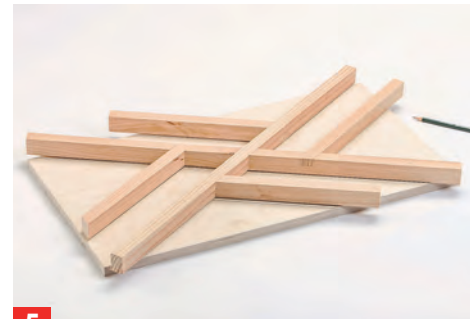
5 An beiden Füllungen die nach innen überstehenden Holzleisten kantenbündig anzeichnen und die Hölzer sauber ablängen.
