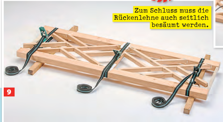
Zum Verleimen und Spannen legen Sie seitlich Distanzhölzer zu. Entfernen Sie den ausgetretenen, getrockneten Klebstoff.
