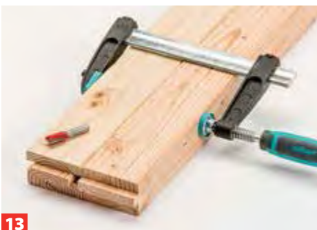
13 Die mittleren Stehholme werden oben und unten beidseitig abgesetzt und erhalten so einen Zapfen – links im Bild ist ein Holm ...
