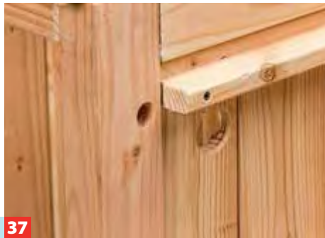
37 Als Auflager für den Grill verkleben und verschrauben Sie rechts und links je eine breite Leiste. Der Grill wird daran festgeschraubt.
