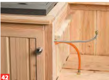
42 Kochfeld festschrauben und Löcher für den Gasschlauch sowie die Gasleitung bohren (beachten Sie die begrenzte Länge).
