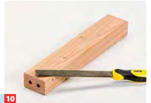
10 Noch fehlen die oberen Distanzhölzer: Dübellöcher bohren, übertragen und alle Anschlussstöße leicht anfasen.
