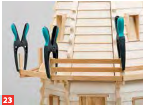
21 ... und schließlich mit den Quadratstab-Ab-schnitten der Balkenausleger verschraubt.
