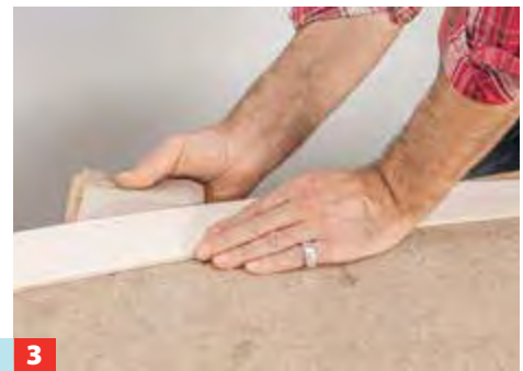
3 Alle Holzteile sorgfältig schleifen. Je exakter die Schablonen sind, desto geringer ist anschließend die Nacharbeit an den Bauteilen.
