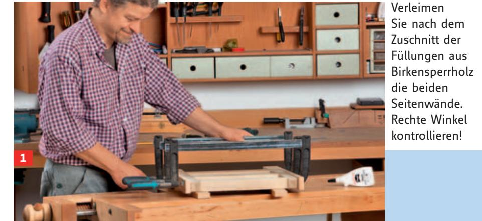
Verleimen Sie nach dem Zuschnitt der Füllungen aus Birkensperrholz die beiden Seitenwände. Rechte Winkel kontrollieren!
