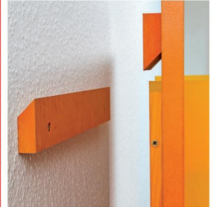
Schwere Gegenstände lassen sich sehr einfach mit schrägeschnittenen Halteleisten aufhängen. Der Winkel ist dabei für die Stabilität relativ unerheblich, sollte jedoch zwischen 30 und 45° liegen. Mit der Stichsäge gelingt der Schnitt auch aus der Hand immer, da beide Leisten mit dem gleichen Schnitt hergestellt werden und daher stets genau passen.
