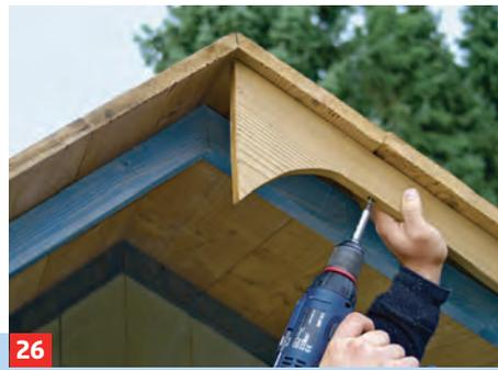
26 Ein Blick in den First: hier das Anschrauben der Dachblende. Die Kontur der Rundung entnehmen Sie der Zeichnung
