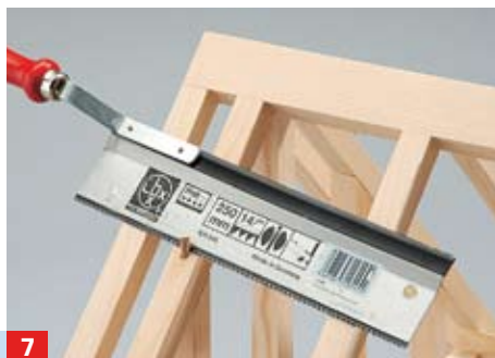
7 ... den jeweiligen Ständer mit Zulagen, bohren senkrecht durch den Sparren und sägen den eingeklebten Dübel bündig ab
