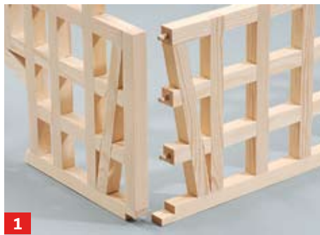
1 Giebel- und Traufseiten werden auch hier mit Dübeln und PU-Kleber verbunden. Geben Sie auch auf die Überblattung ...
