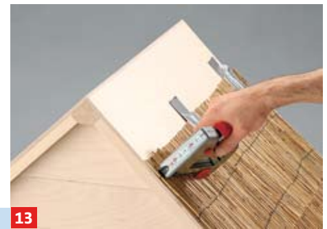
13 Schilfrohrmatten zuschneiden und in drei Lagen je Dachfläche überlappend mit Edelstahlklammern ...
