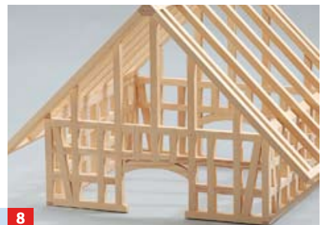
8 Richtfest: Das komplette Ständerwerk des Fachwerkgebäudes steht. Die Flächen werden nun noch teilweise geschlossen
