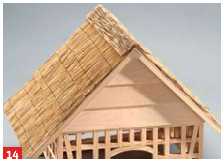
14 ... anheften. Der First wird mit einer Querlage Schilfrohr abgedeckt und ebenfalls mit Edelstahlklammern fixiert
