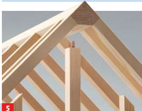
5 Senkrecht ein Dübelloch in die mittleren Ständer der Giebelwände bohren, Dübelstifte einstecken und Dach exakt ausrichten
