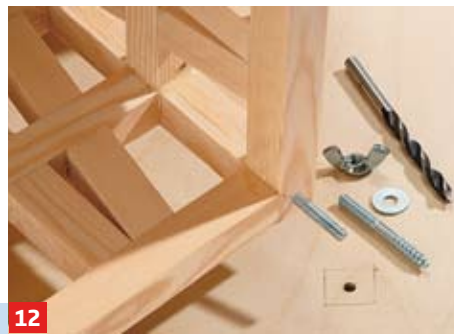
12 Mindestens in zwei diagonal gegenüberliegende Eckpfosten Stockschrauben setzen und das Haus auf die Grundplatte schrauben
