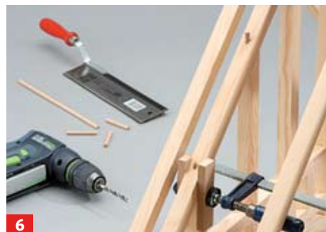
6 Die 4 weiteren Ständer werden über Durchgangsdübel mit dem aufliegenden Sparren verbunden. Fixieren Sie dazu ...
