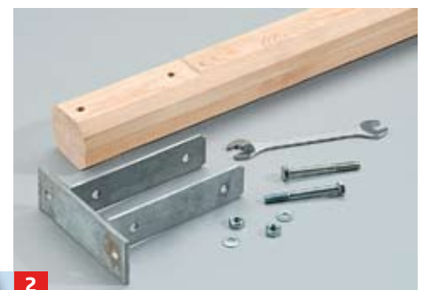
2 Passen Sie das untere Ende des Balkens in den Pfostenschuh ein und verschrauben die Bauteile mit Maschinenschrauben
